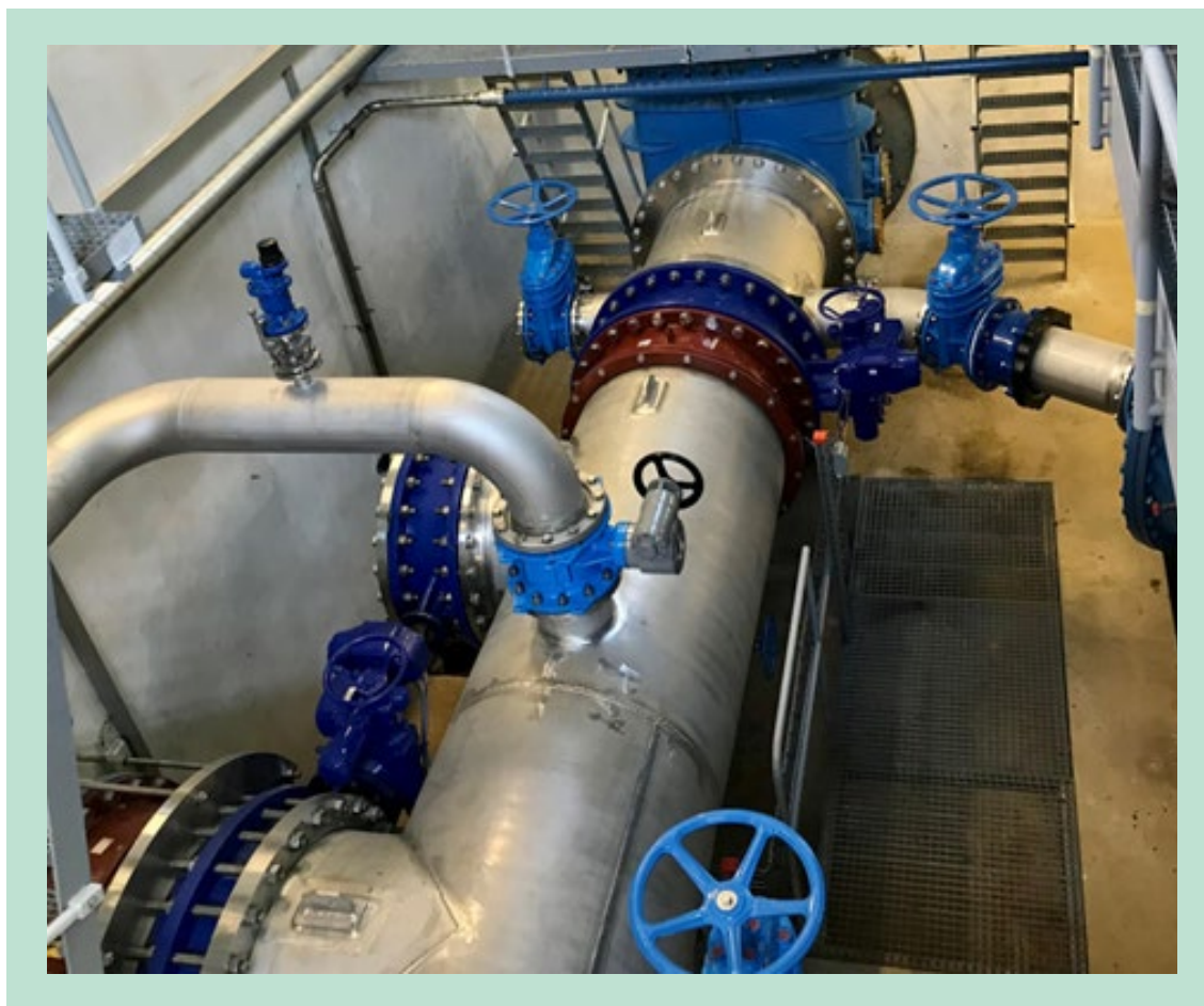
FIGUR 1. Eksempel på skyde- og trykreducerende ventiler coatet indvendigt med pulver-epoxy. Ventilerne er de blå dele vist på et foto fra et vandværk (Kilde: Lone Tolstrup Karlby, HOFOR, Følgegruppemøde 23. september, 2022).
