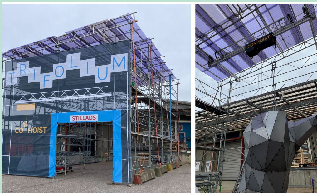
FIGUR 23. Tv.: Test-opstilling på 12x6 m til test af samkørsel af projektets udviklingsspor. Th.: Conhoist under en konkret afprøvning i færd med at hejse og flytte en stålskulptur.
