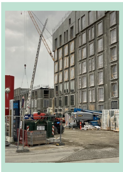
FIGUR 12. Facademontage af vinduer. I denne type montagesituation kan vind udgøre et problem i forhold til at styre vinduerne.
