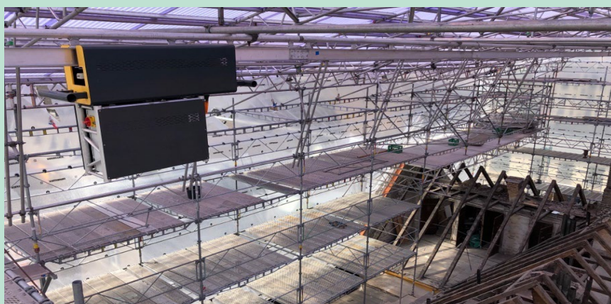
FIGUR 15. På billedet ses Conhoist på det site hvor der blev lavet iagttagelser af faktorer der kan resultere i svingende laster. Som det ses, er sitet pakket ind i vindskærmende stilladsdug og vind er derfor ikke en væsentlig faktor i den sammenhæng.
