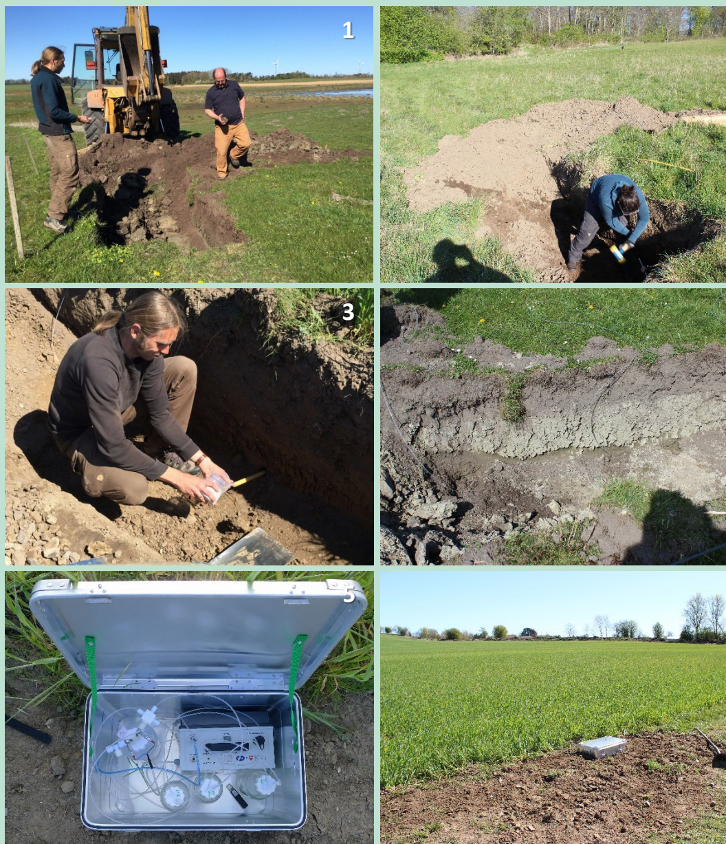
FIGUR 10. Installation af sugeceller. 1. Gravning af arbejdshul (lokalitet 2). 2. Bankning af installationshul (lokalitet Sv4). 3. Silikamel-opslæmning hældes i bunden af hullet før sugecellen installeres. 4. Sugeceller installeret med slanger stikkende ud i ca. 70 cm dybde (lokalitet 2). 5. Installation af flasker, overløbsflaske og pumpe i alu-case. 6. Færdig installation (lokalitet 3).
