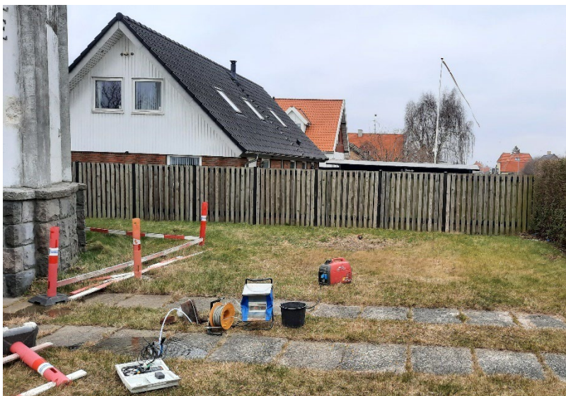
Prøvetagning i dén boring, som gav den højeste DMS-koncentration (0,33 µg/L, filter placeret 4-9 meter under vandspejlet). Denne boring er centralt placeret i det største og mest homogene villa-område i Hvidovre
