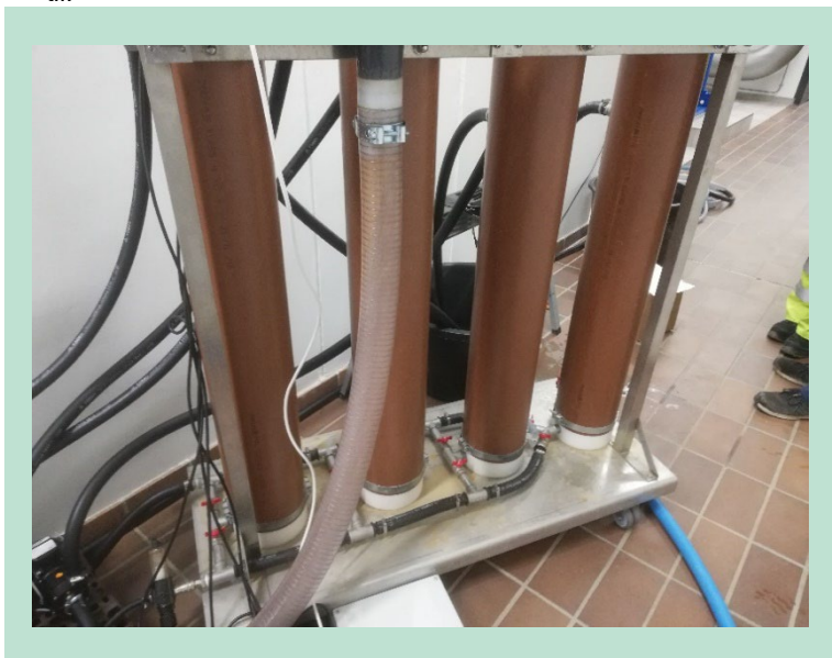
FIGUR 4. Udløb fra testkolonnerne.
