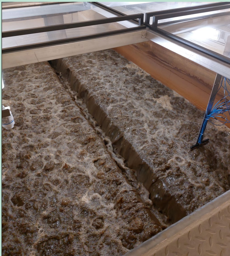
FIGUR 24. Billede fra filterskyl af biofilteret (filter 6) efter 6 ugers drift. Bemærk skyllevandets sorte farve.
