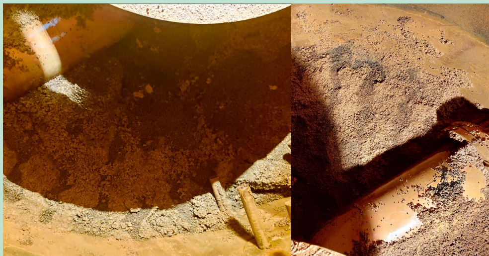
FIGUR 33. Marmoreringen med tendenser til sammenkittede filtermaterialer. Marmoreringen har baggrund i placeringen af luftharpen.
