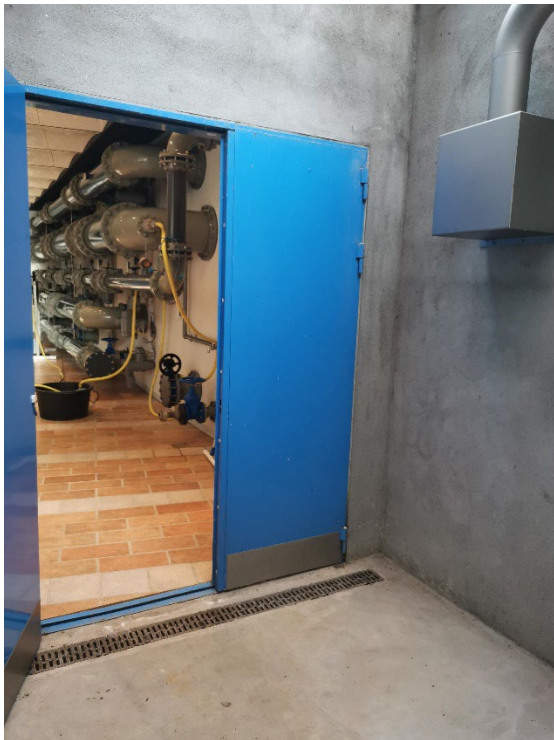
Højde i kælderskakt 3,43 m
