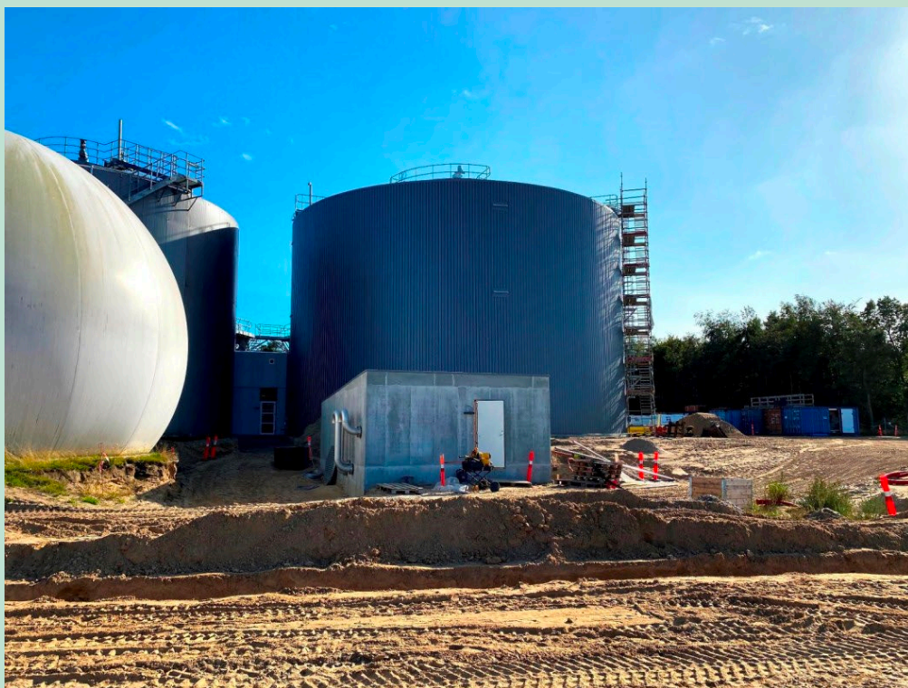
FIGUR 8. Rådnertank og kondensatbrønd under opførelse.
