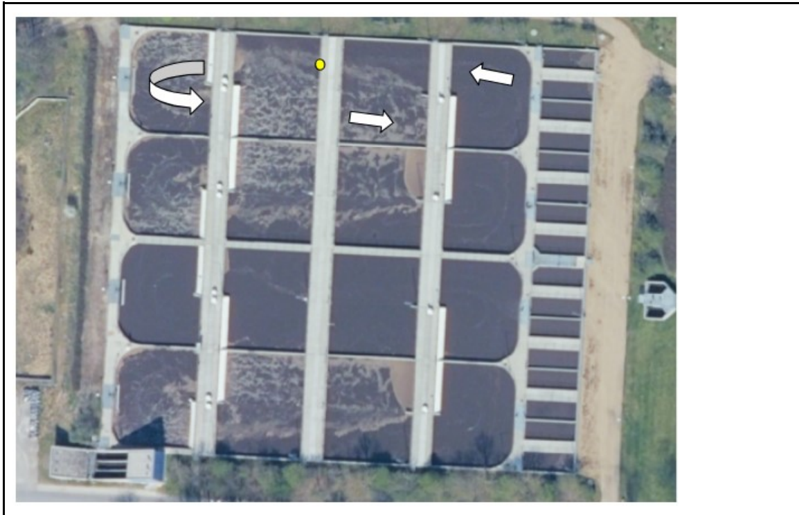
Case E: Næstved (NK - Spildevand A/S renseanlæg) - overfladebeluftet anlæg
