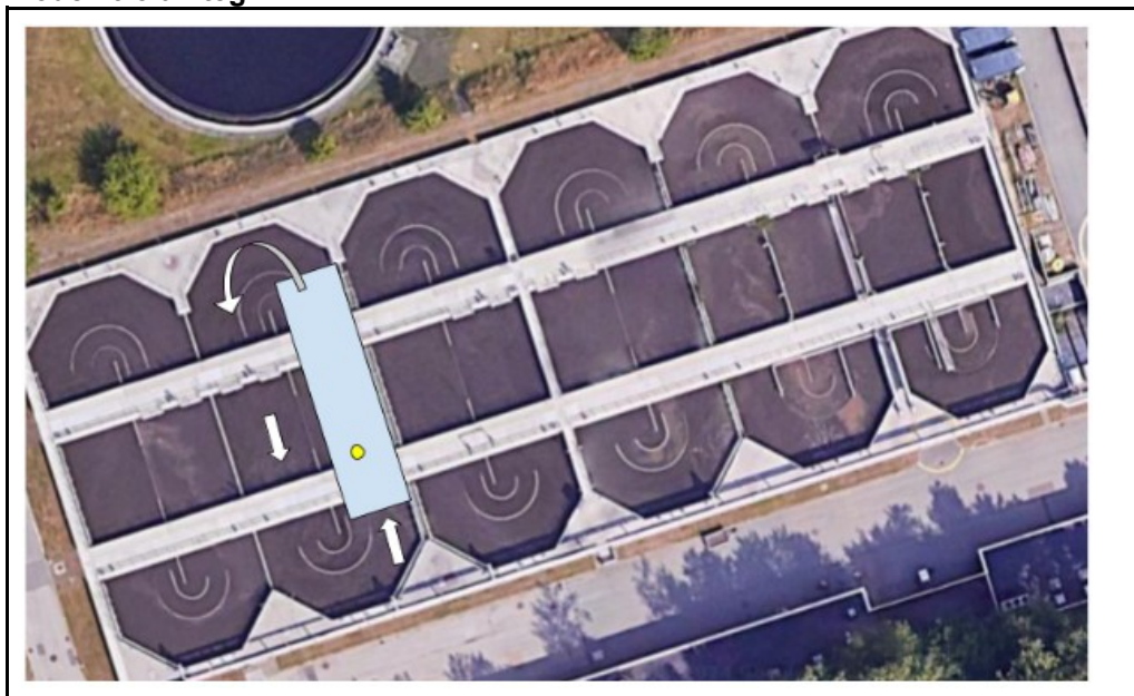
Case B: Mølleåværket renselanlæg - et biodenitro anlæg med bundbeluftning
