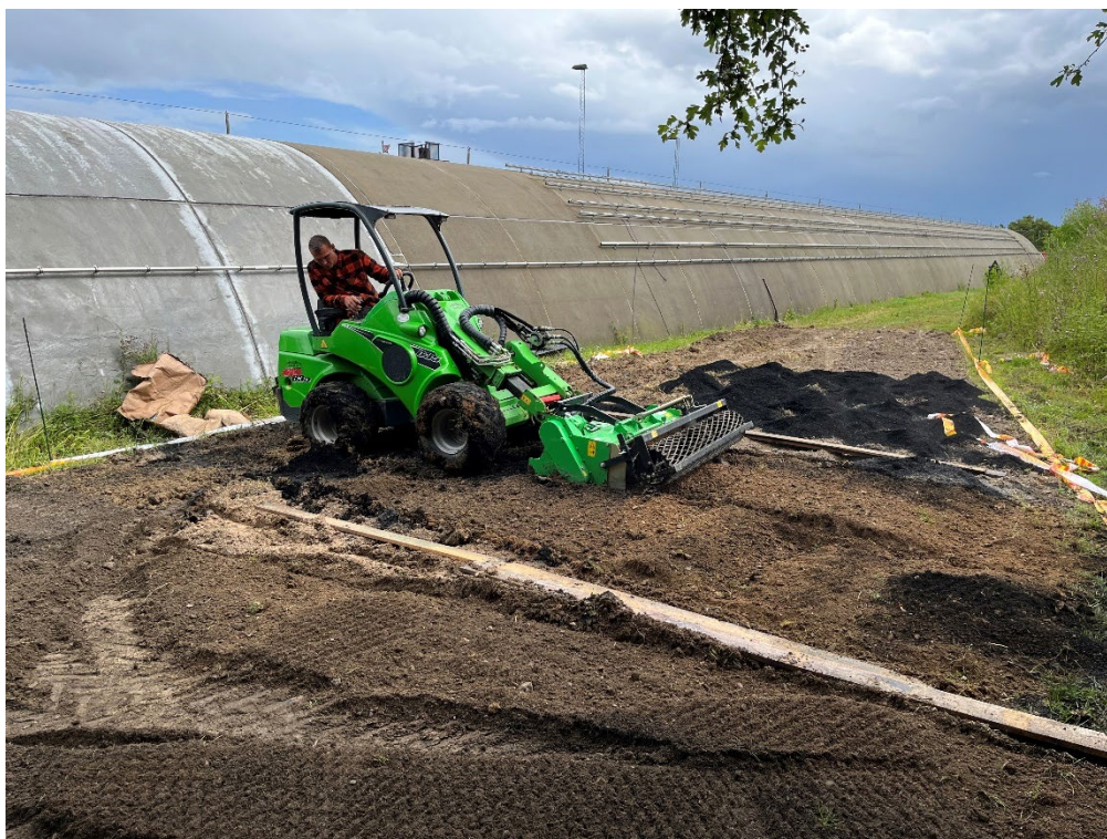
BAM Ex udlægges i felt 3 – bag fræseren, mens felt 4 fræses.
