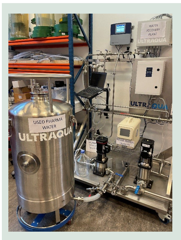
FIGUR 8-1. Mobile tanke anvendes til opsamling af brugt procesvand og andre ressourcer, der efterfølgende bringes til rensning vha centraliseret CIP, der er integreret i anlægget til opsamling og forbehandling af brugt procesvand.
