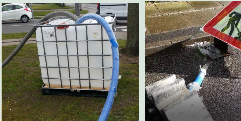
FIGUR 3. Til venstre: Midlertidig opsamlingstank til udløbet med afløbsslangen vand vandledningen (blå) og tømningsslange til slamsuger (grå), Venusvej. Til højre: afledning til kloak, Esagervej.
