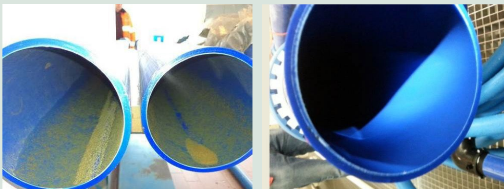
FIGUR 30. PEM rør til testrig ved opgravning (venstre) og efter Ice Pigging (højre).
