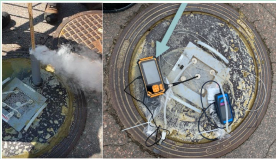
FIGUR 35. Billeder fra injektion af røggas og registrering via endoskopkamera (Kilde: NIRAS A/S og SGU, Sveriges Geologiska Undersökning).
