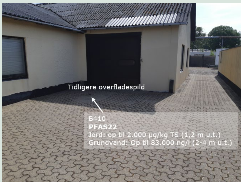
FIGUR 16. Testområde på lokalitet 1. Tidligere er der udført en enkelt boring i området (B410).
