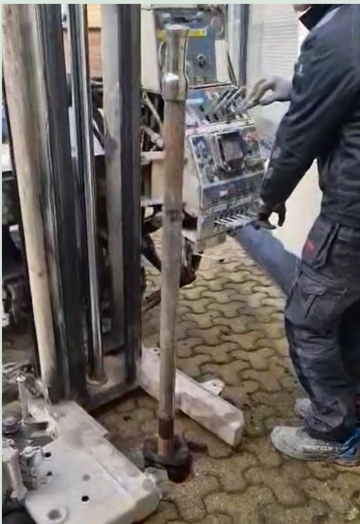
FIGUR 18. Etablering af DT2 med Geoprobe® 16 m u.t. På billedet ses Geoprobens lukkede forerør, der rammes ned til 20 cm over ønsket installationsdybde. Herefter kan sugecellen monteres på en specialdesignet dorn, der påsættes på Geoprobens arbejdsrør. Sugecellen rammes efterfølgende 20 cm dybere ned til ønsket installationsdybde.
