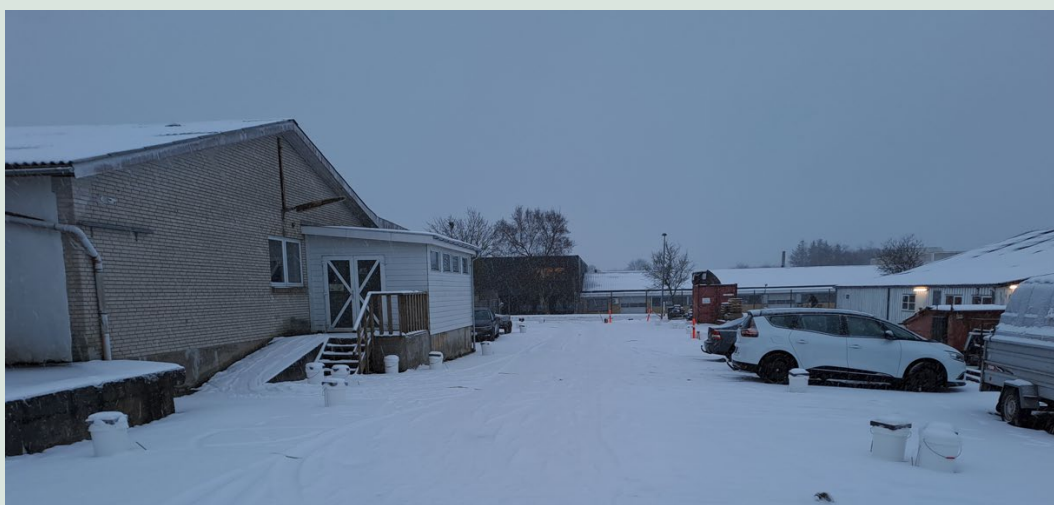
FIGUR 25. Testområde efter installation af sugeceller. Vakuumflaskerne opbevares i de hvide spande. Flere steder blev der etableret stålslanger under grusbelægningen for at muliggøre kørsel på kørevejene i undersøgelsesområdet.
