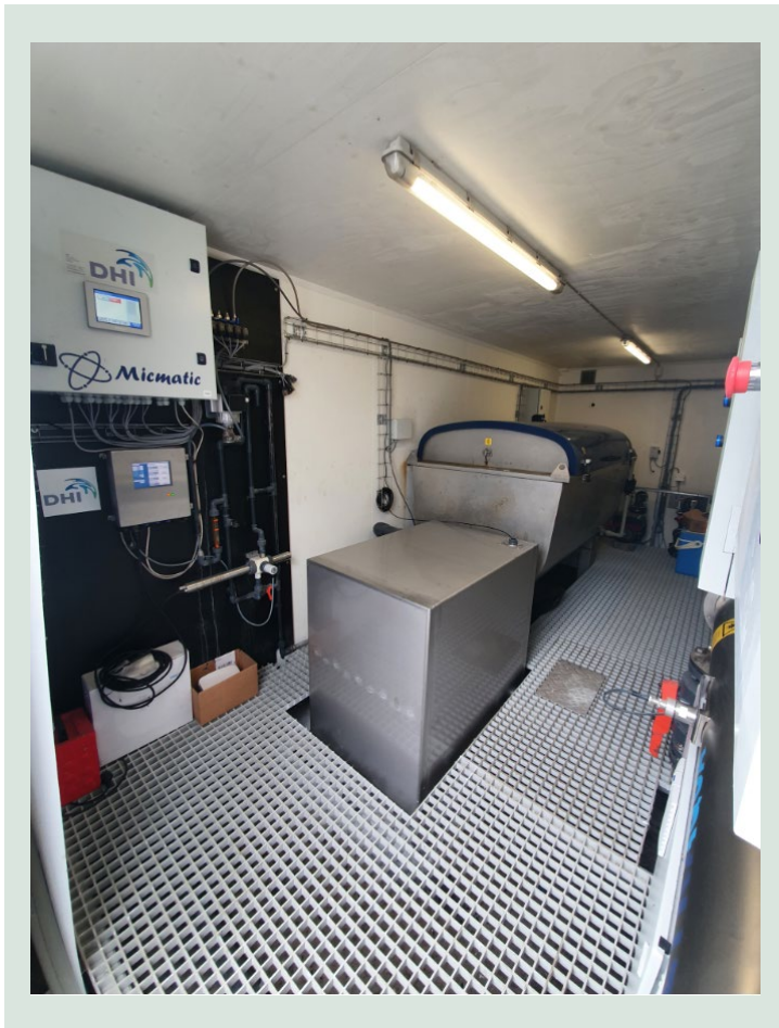
FIGUR 8-2. Foto af pilot-container med tromlefilter og traditionel UV (nederst til højre).
