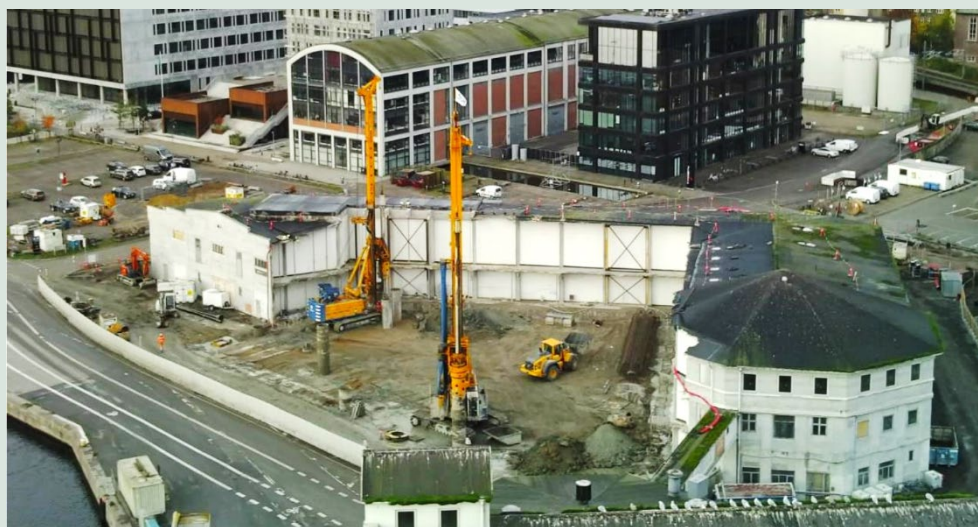
FIGUR 7. Byggeplads set af et time-lapse kamera på en nabobygning.
