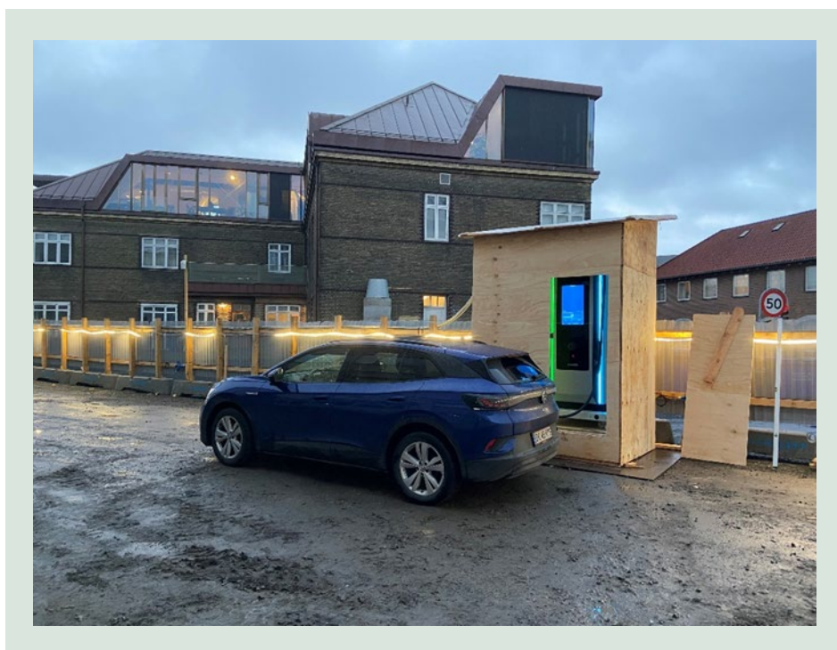
FIGUR 32. 300 kW lynlader installeret på byggepladsen.
