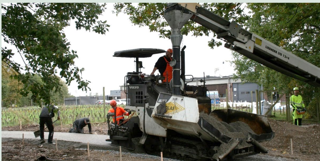
FIGUR 26. Testfelt ved Teknologisk Institut udlagt med asfaltudlægger.
