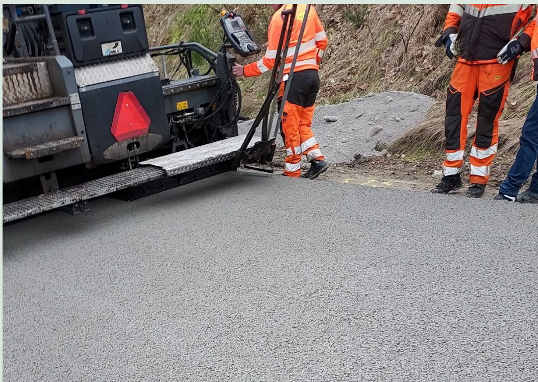
FIGUR 24. Testfelt 3 ved Viborg, hvor der er anvendt asfaltudlægger. Foto: Unicon.
