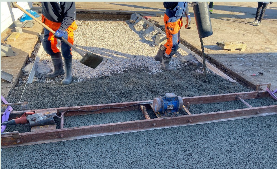
FIGUR 20. Udlægning af testfelt ved Aarsleff med bjælkevibrator.
