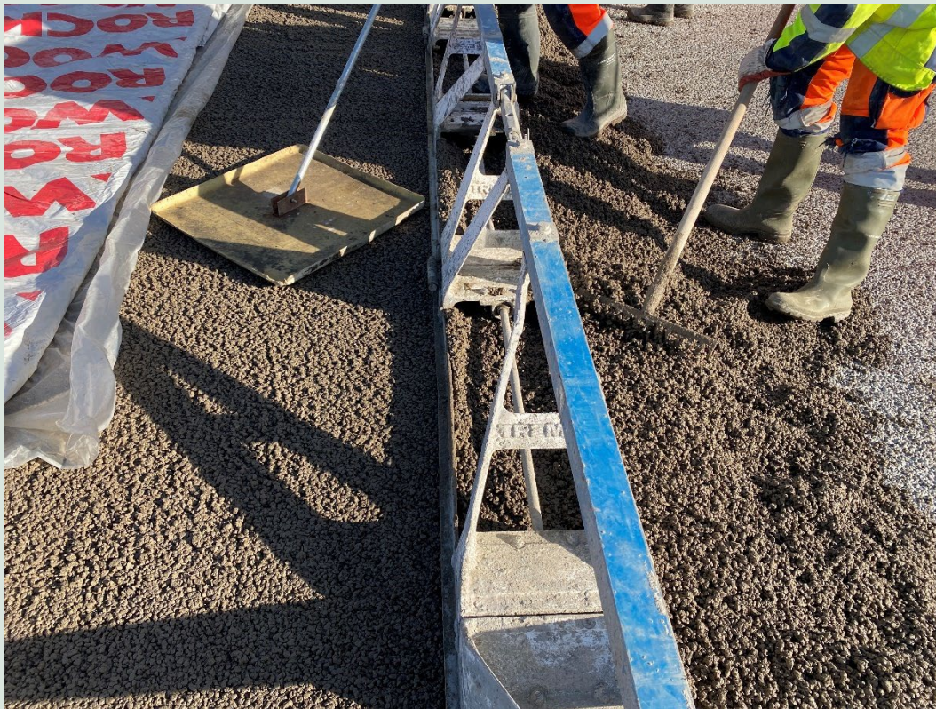
FIGUR 23. Testfelt 2 hos Unicon, hvor den anvendte bjælkevibrator ses.
