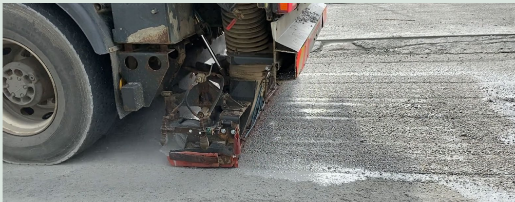
FIGUR 29. Oprensning af permeabel befæstelse.
