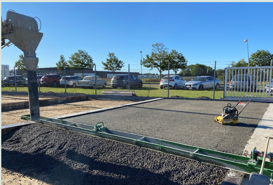
FIGUR 21. Testfelt 1 hos Unicon, hvor den anvendte bjælkevibrator og pladevibrator ses.
