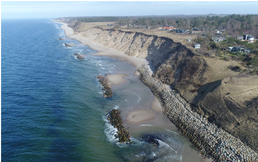
Figur 5.5 Bølgebrydere med kompenserende sandfodring
