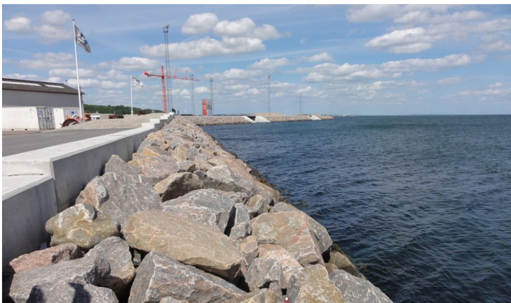
Figur 5.3 Bølgebrydende skråningsbeskyttelse med undersøisk banket
