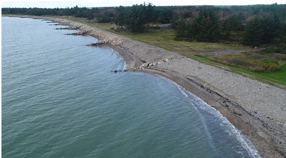
Figur 5.9 Dige beliggende på forstrand udsat for erosion
