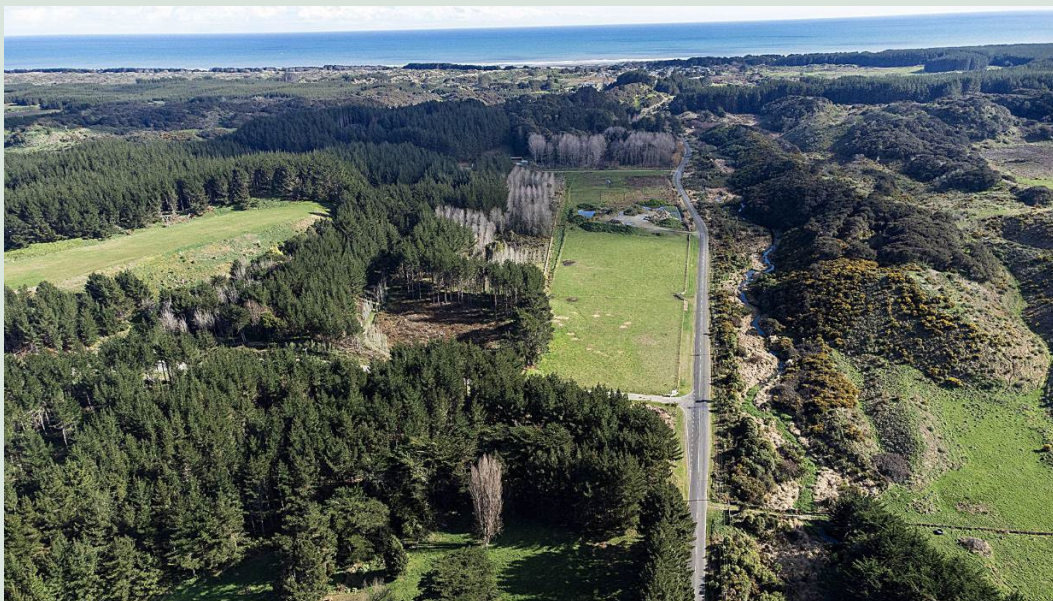
FIGUR 34. Levin Losseplads, New Zealand. Lossepladsen ses til venstre i fotoet. Der er en forureningsfane som strømmer til højre med udledning til Hokio Stream til højre i fotoet ( https://www.thepost.co.nz/nz-news/350431604/council-taking-measures-stop-leachate-plume-reaching-stream ).
