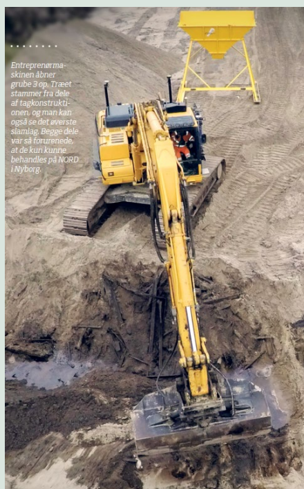
FIGUR 19. Oprensning ved udgravning ved Kærsgaard Klitplantage (Region Syddanmark, 2025)
