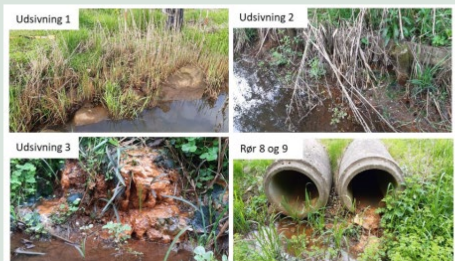
FIGUR 15. Dræn med udsivning af perkolat til overfladevand ved Holmene Losseplads (219-00050, Region Hovedstaden) (DMR, 2023)
