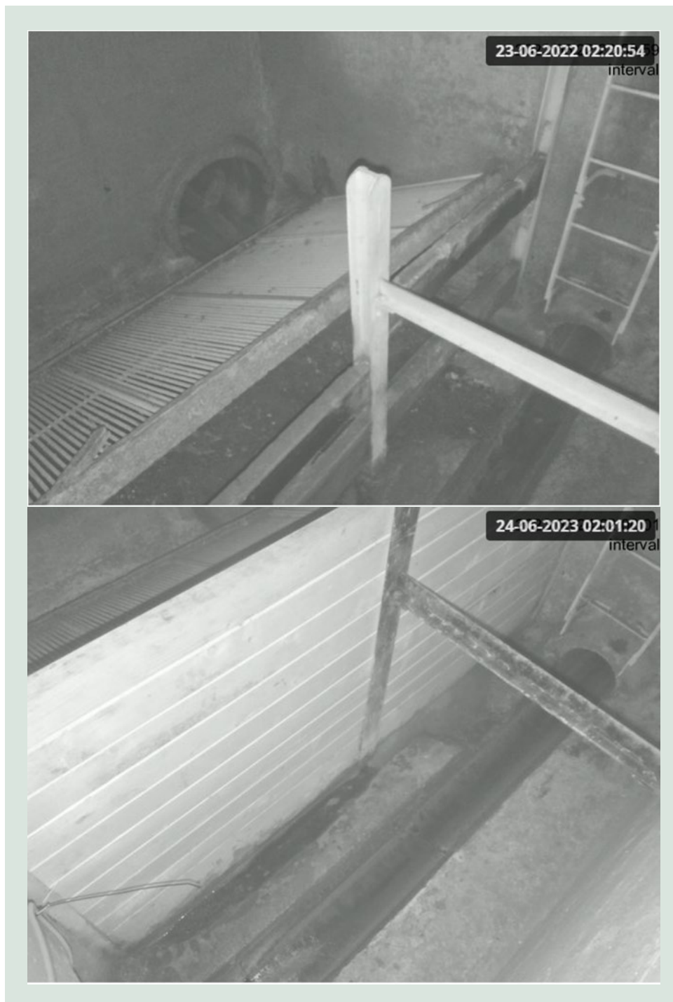
FIGUR 104. Overløbet Lindevangsvej før og efter ombygning.
