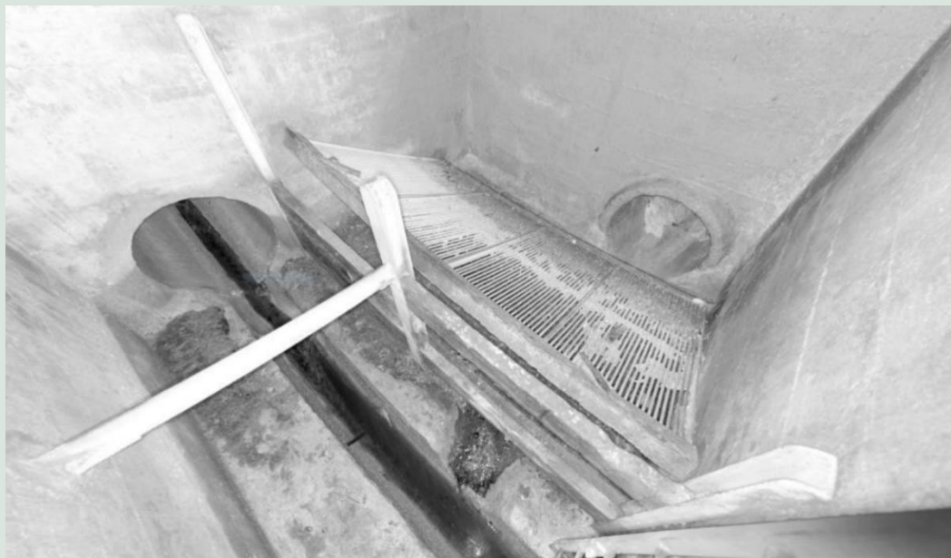
FIGUR 16. Bygværket i Lindevangsvej før ombygning.
