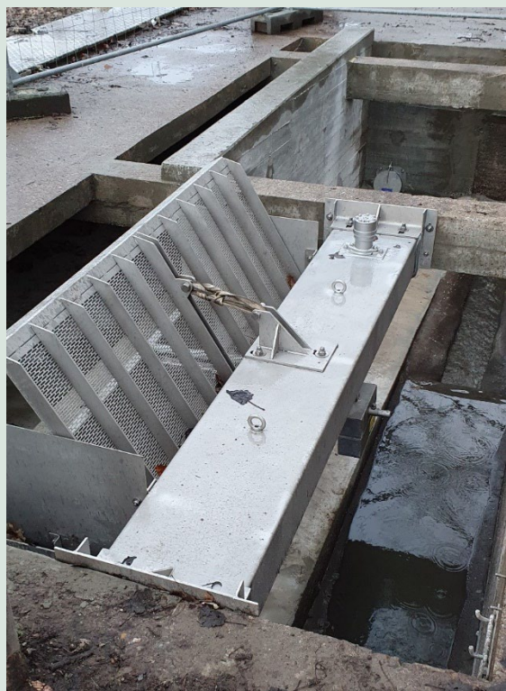
FIGUR 108. Billede af rist i bygværket på Thulevej.
