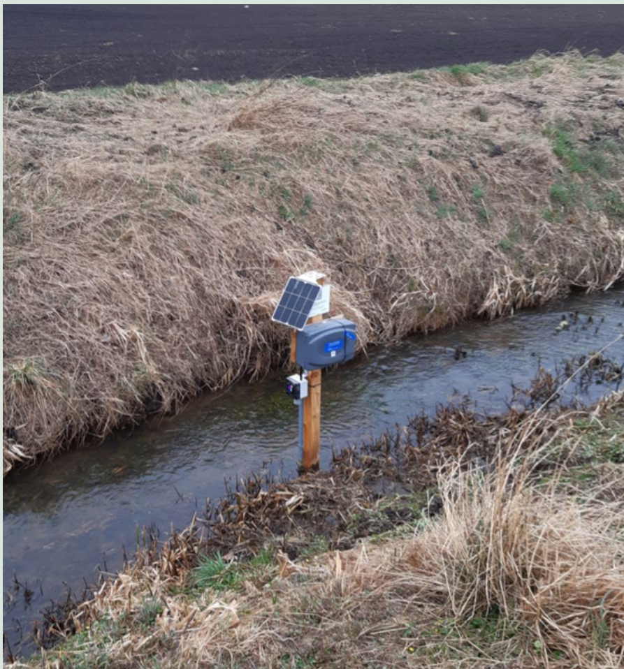
FIGUR 31. Målestation med solcellepanel og vandkvalitetsmåler samt niveaumåler.
