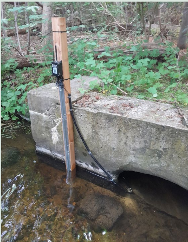
FIGUR 57. Billede af temperaturmålestation nær Mårslet skole (ID:4420) ved lav vandstand.
