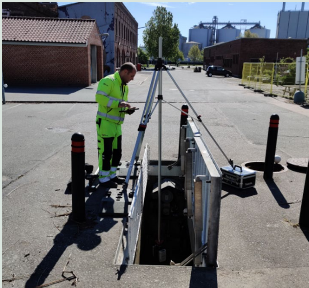
FIGUR 62. Opmåling af bygværk med laser (Kilde: Aarhus Vand).
