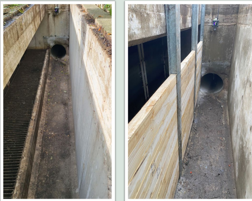
FIGUR 101. Overløbet Annexgården før og efter ombygning.
