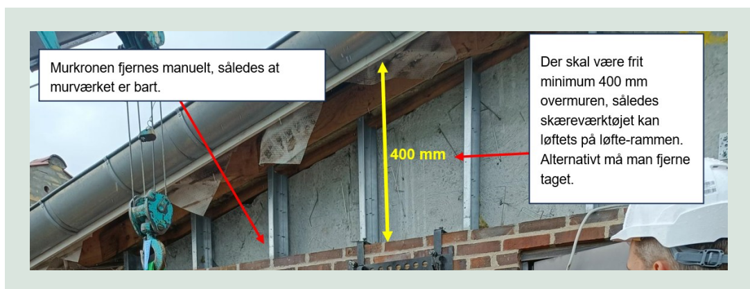
FIGUR 3.3. Illustration af klargøring af murkrone.
