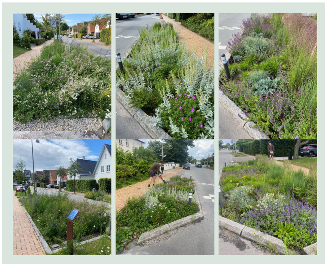
FIGUR 5.45. LAR-vejbede på Langelinie i 2021 (øverst) versus 2024 (nederst). Yderst til venstre ses test-bede (nr. 124 og 116), type A i midten (nr. 81 og 105), type B til højre (nr. 87 og 104) (Foto: MCB).
