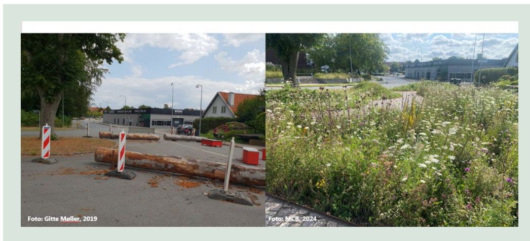
FIGUR 4.3. Eksempel på eksisterende LAR-anlæg Træøen, Bolbro i Odense (Foto: MCB).
