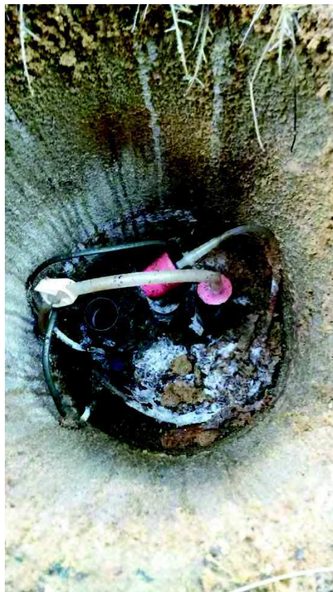
Foto 8: Indretning af boring B14.
