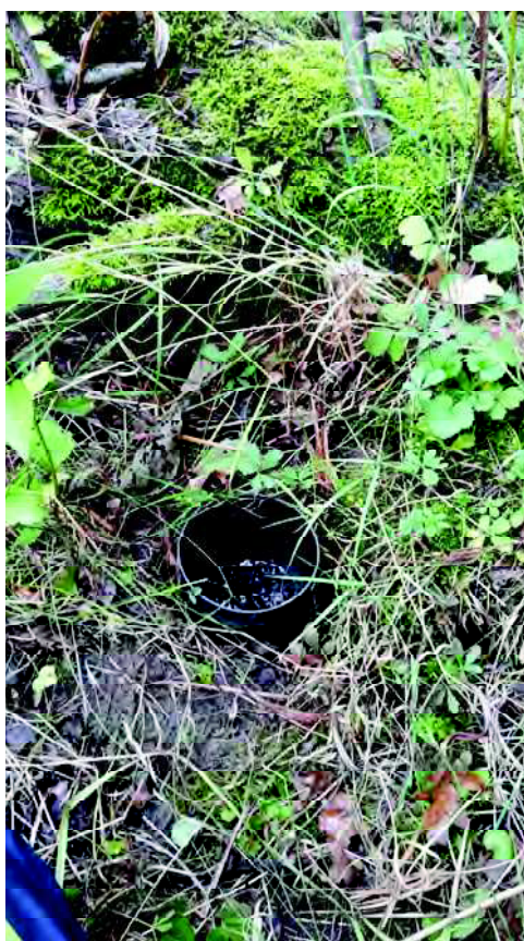
Foto 6: Sort plasticrør observeret på lossepladsarealet.
