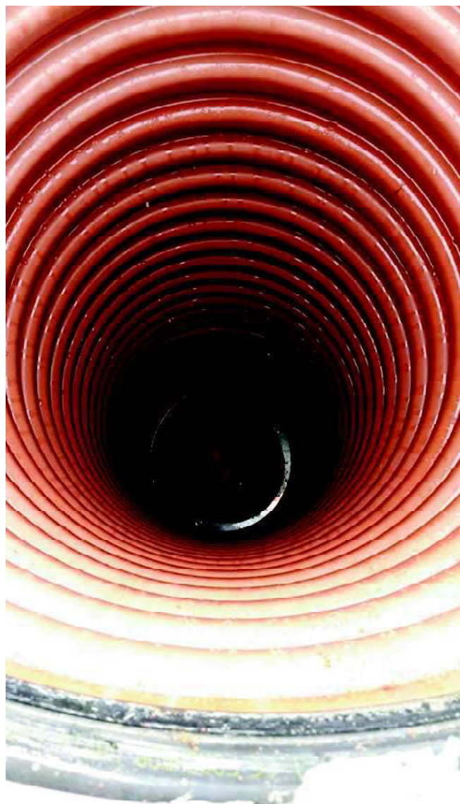
Foto 10: Gasindvindingsboring PB8 afsluttet under terræn.
