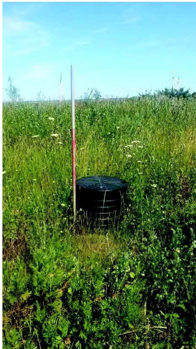
Foto 6: Eksempel på gasindvindingsboring.
