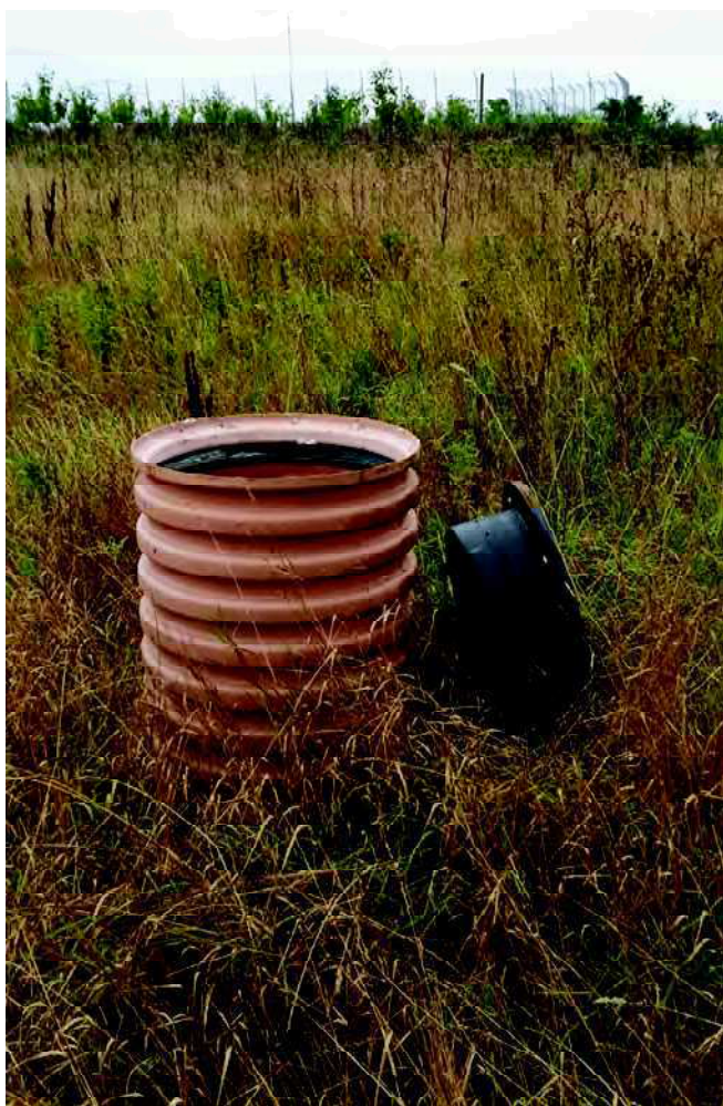
Foto 9: Gasindvindingsboring PB8.
