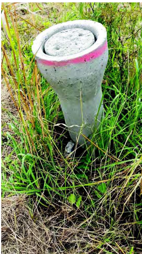
Foto 13: Brud på boring B208.
