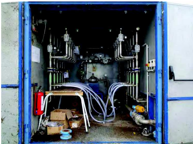
Foto 15: Manifold. Strengene fra de otte gasindvindingsboringer og de to horisontale gasdræn er samlet i en manifold med henblik på IR-målinger under passive forhold.
