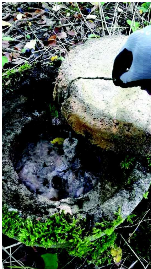
Foto 10: Indretning af boring B15.
