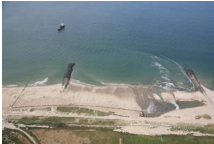
Indpumpning med bundliggende rørledning, hvor sandet fordeles parallelt med stranden.
