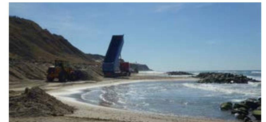
Indbygning af sand transporteret over land.
