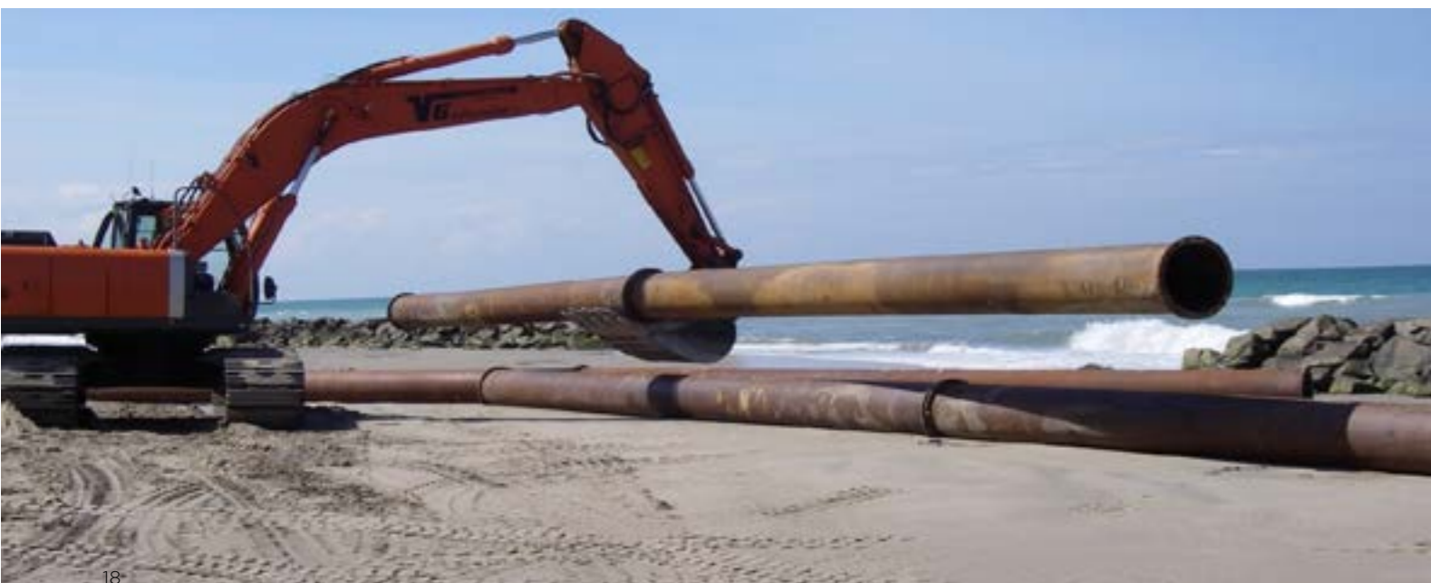
Arbejde med maskiner i forbindelse med strandfodring.
