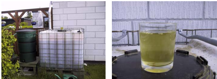
Figur 3.1 Eksempel på system til opsamling af tagvand. Vandet i glasset vist til højre er en prøve på indholdet i den gennemsigtige beholder. Foto: COWI (Karsten Arnbjerg).
