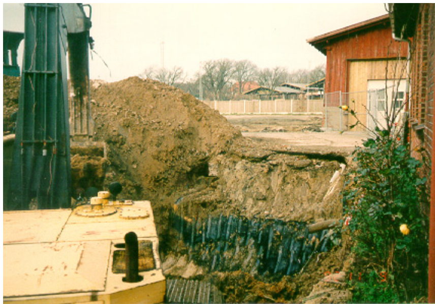
Figur 2.4: Bortgravning af tjæretank 1, 1992. Kraftig tjæreforurening fra ca. 1,5 m.u.t.
