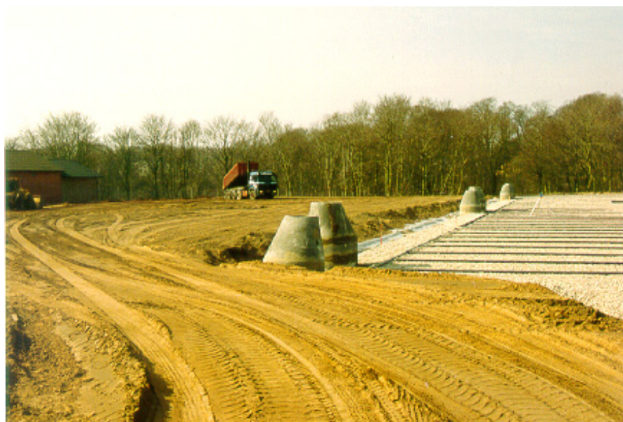
Figur 2.7: Etablering af infiltrationsanlægget på Hjørring Gasværk. Fordelingsbrønde og infiltrationsstrenge udlagt på nøddestenslaget.
