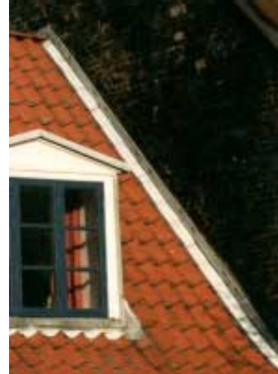
Figur 2: Skrå sammenskæring. Her er en traditionel blyinddækning mellem tegltag og mur.
