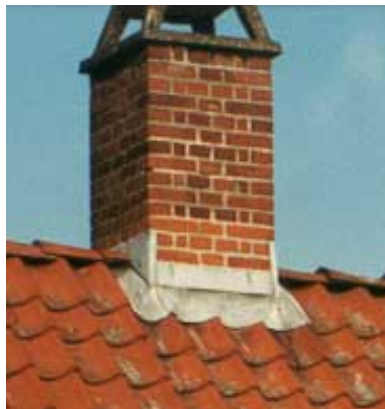
Figur 14. Skorsten i tagets kip med blyinddækning
