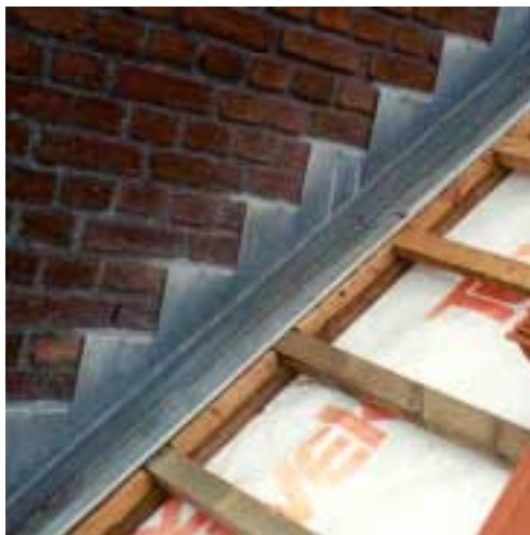
Figur 5 Inddækning med siderende, før pålægning af tagmateriale
