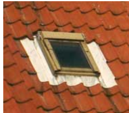
Figur 24. Inddækning af et ovenlysvindue med tilpasset blyplade
