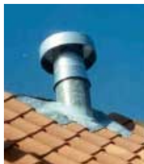
Figur 17. Inddækning af ventilationsgennemføring. Blykappe loddet på zinkrør
