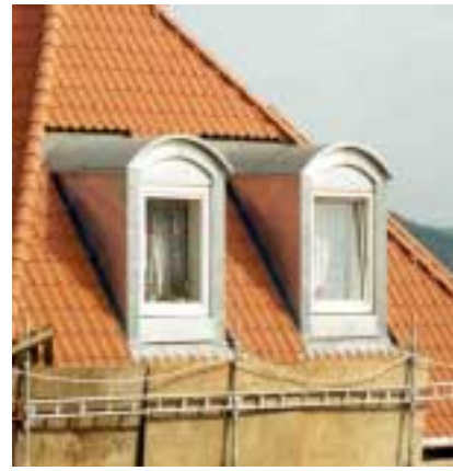
Figur 22. Zinkinddækning af en kvist på tegltag. Forkant er inddækket med bly.
