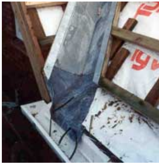
Figur 26. Skotrende af zink og overgangsstykke af bly.
