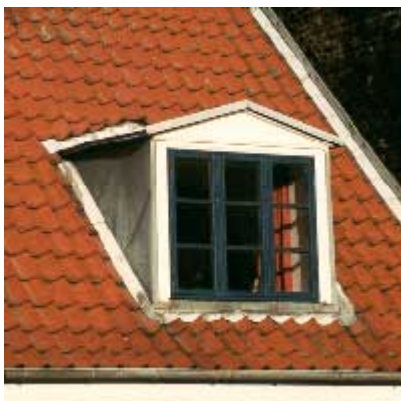
Figur 20. Bly- og zinkinddækning af en kvist
