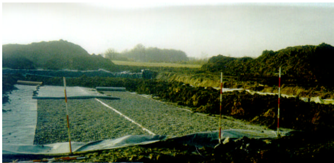
4 Stenlag med fibertextdug og fordelerrør.
