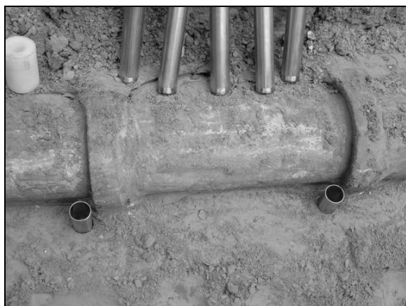
Foto 4-8: Udtagning af prøver under kloakledningen i Strøybergsvej. Nederst ses prøverør der er nedbanket i jorden, øverst ses ubrugte rør.
