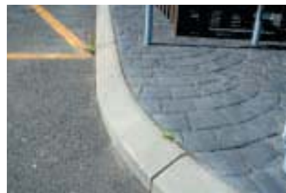
Sammenhængende belægning af beton, hvor mønstret er lavet med et net i den våde belægning.
