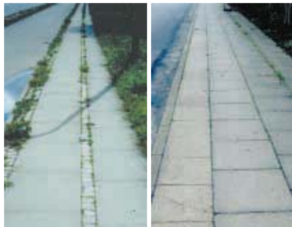
Udformningen af fortovet har stor betydning for fugearealet og dermed mængden af ukrudt. Med chausséstensbånd er fugearealet ca. 8 % og uden ca. 4 %.
