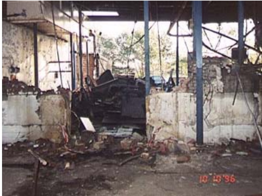
Figur Error! Unknown switch argument.: Billede fra fabriksrumtaget 3 år efter nedrivningen (1996)
