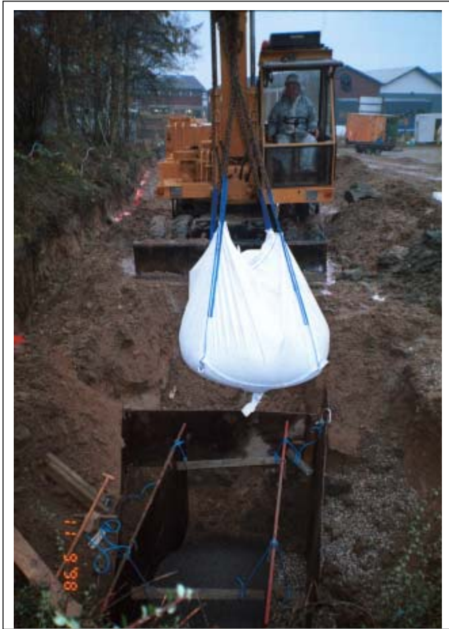
Figur 6: Jernspåner fyldes i flydekasse. 1. sektion af den reaktive væg
