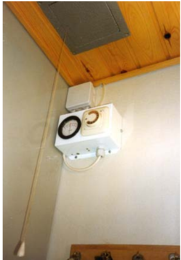
Kontrolboks med omdrejningsregulator og manometer, monteret i bryggers
