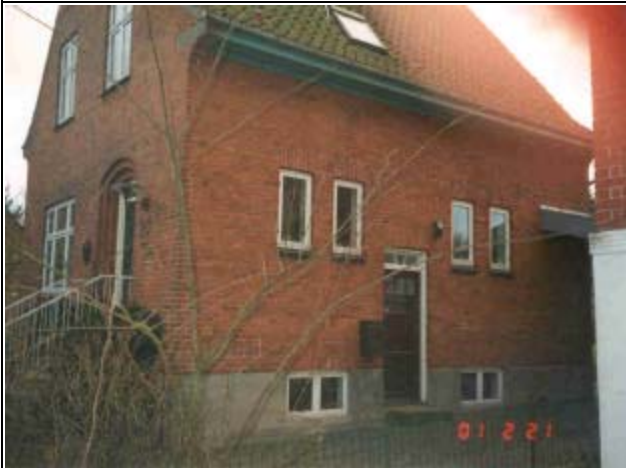
Patriciavilla - fuld kælder (aflukning til stueetage mulig)
