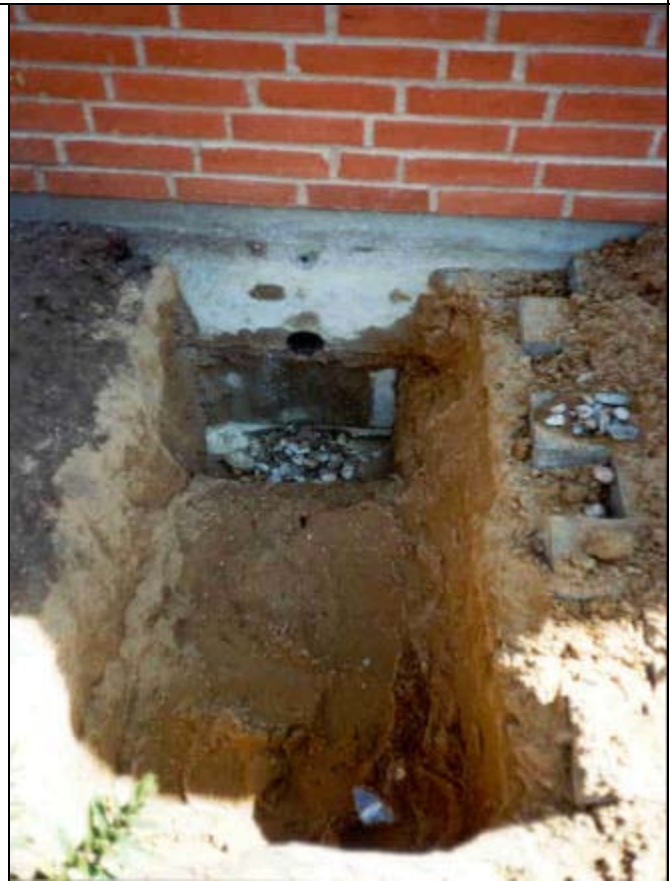
Frigravning af fundament (installation af dræn)
