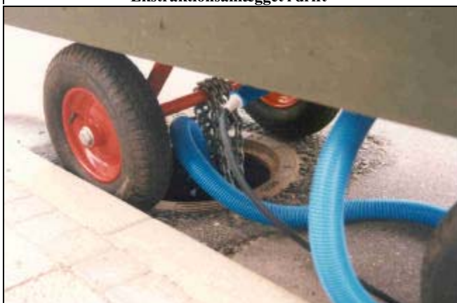
Anlægget parkeres direkte over boringen
