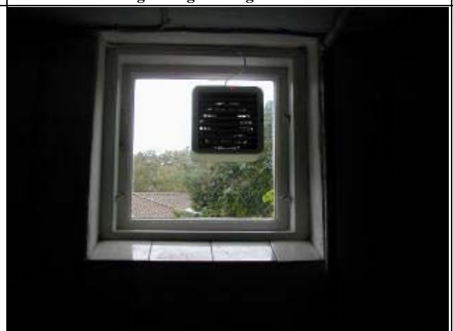
Ventilator – vinduesmontage, tændt
