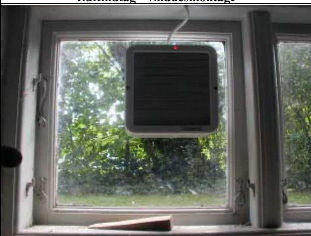
Ventilator – vinduesmontage, slukket
