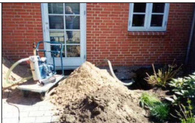
Ventilationstest efter endt installation
