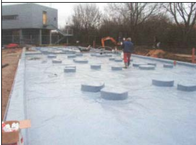
Membranen udlagt på terrændæk (med påsvejsede membrankraver)
