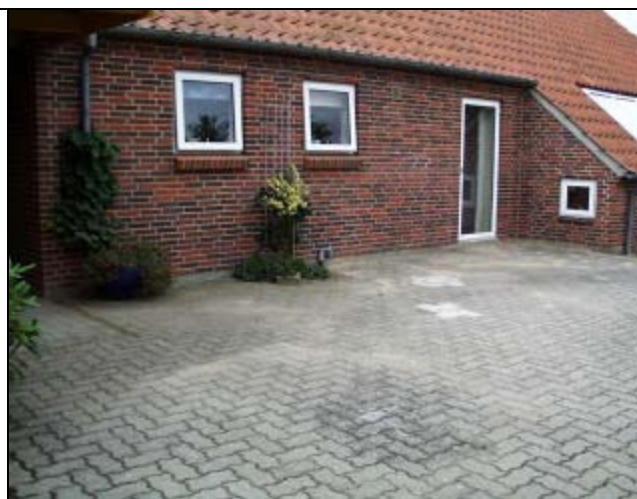
Facade friholdt for overjordisk rørføring
