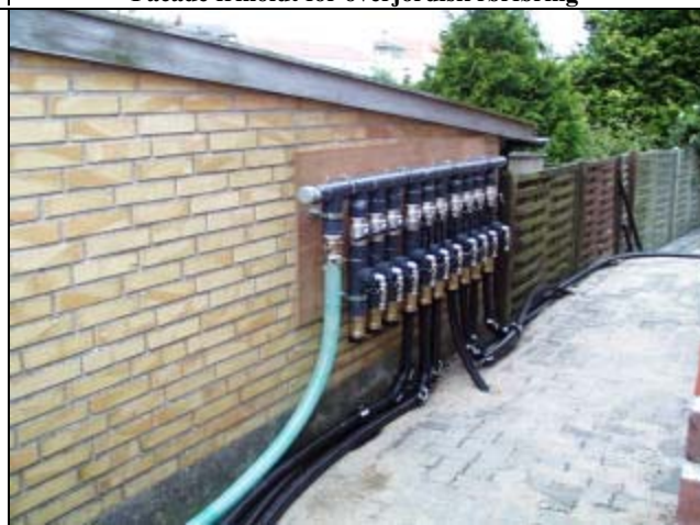
Manifold (7 stk. dræn i drift, forberedt for 10 stk.)
