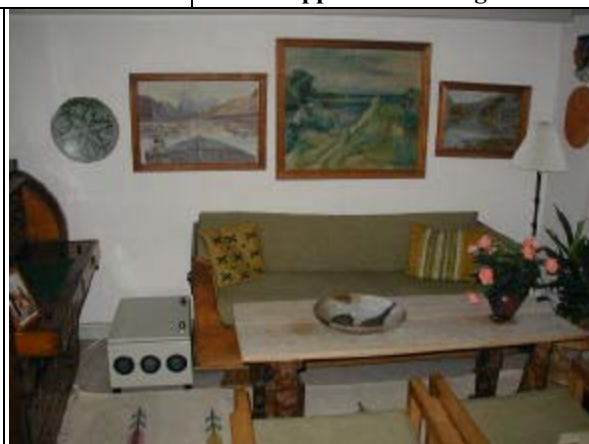
Luftrensner i stue - udblæsningsdyser rettet ud i lokalet
