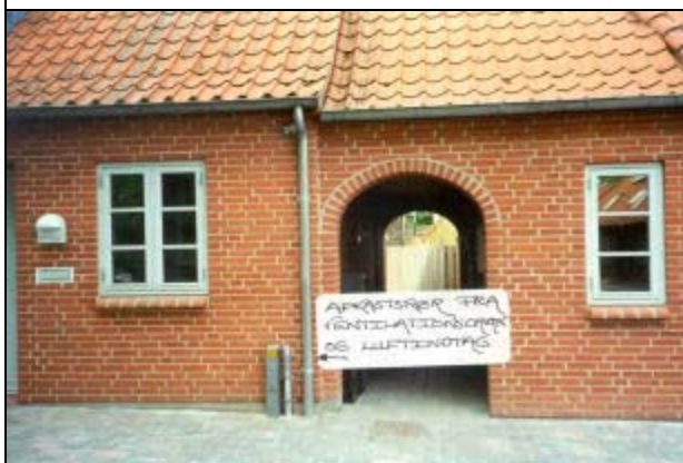
Afkastrør fra ventilationsdræn samt luftindtag
