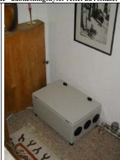
Udblæsningsdyser rettet ud i lokalet
