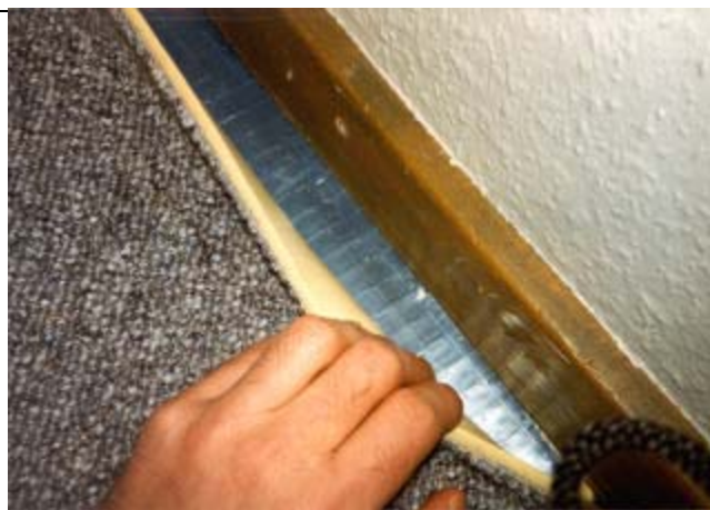
Membran monteret under tæppe i eksisterende bolig
