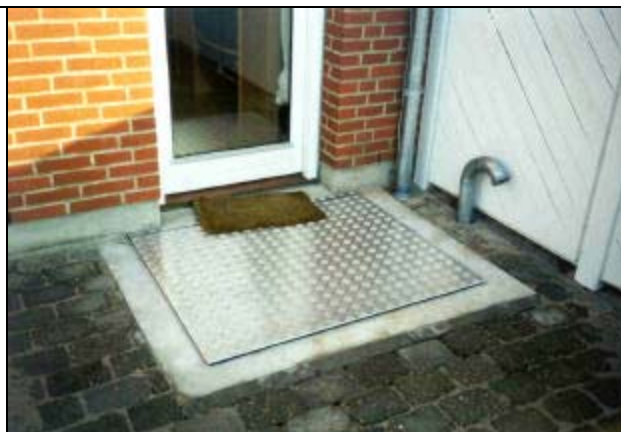
Lydisoleret dækplade i aluminium
