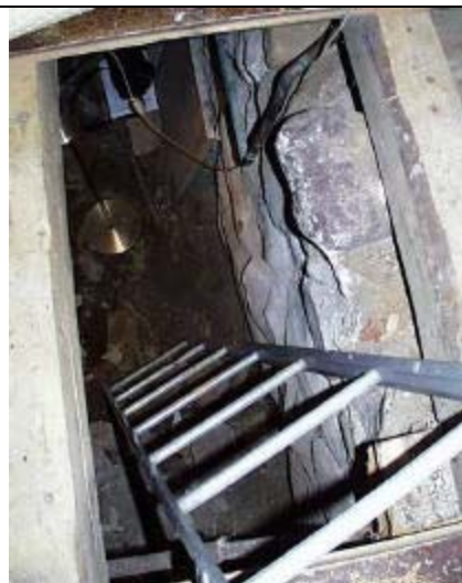
Nedgang til lukket kælder
