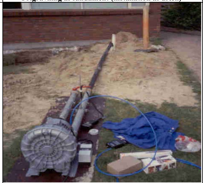
Maskinel indboring af dræn
