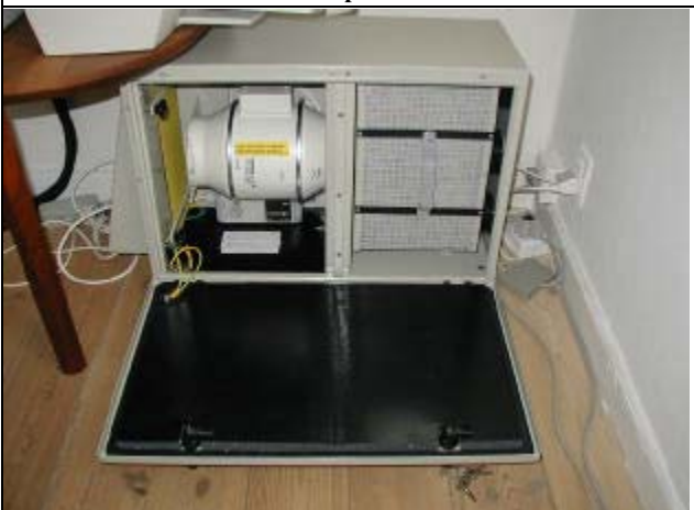
Opbygning af luftrensere (ventilatorenhed tv. og kulfilter th.)
