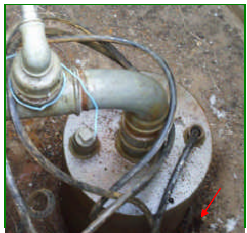
Figur 6. Lysning ved kabelgennemføring
