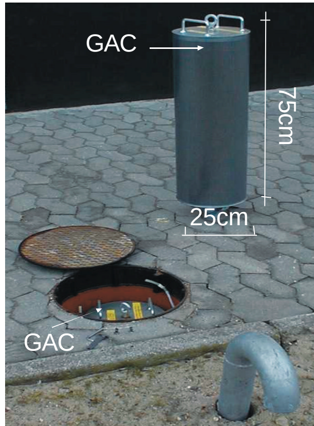
Figur 4.2 Standard system med GAC-enhed i brønd på Prins Valdemars Alle 14, Allerød.
