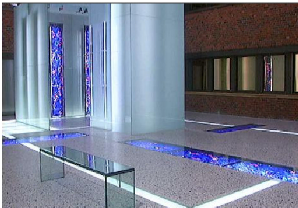
Figur 1: Wiedemann-salen på Steinkjer Rådhus (Norge) med glasmalerier og gulv af beton med glastilslag. Gulvet er slebet for at fremhæve tilslagets blå farve. [2].
