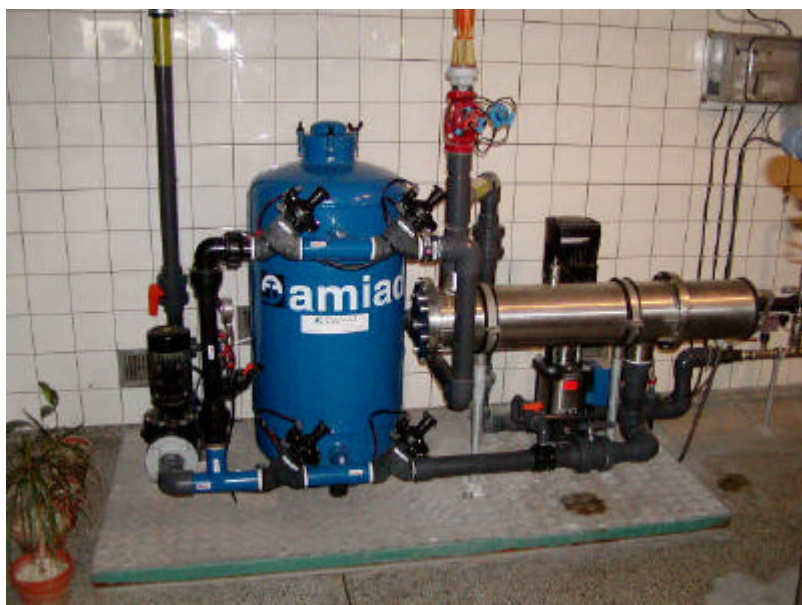
Sandfilter og UV-filter
