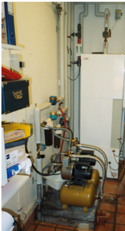
Grävands- og regnvandsanlæg, LEV - huset
