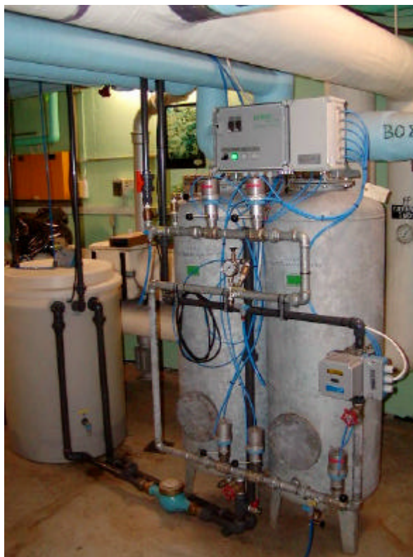
Figur 29: Sandfilteranlæg, Vestbadet
