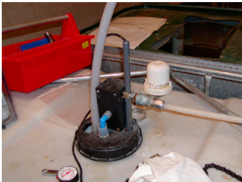
Spædevandstilførsel til rentvandstank
