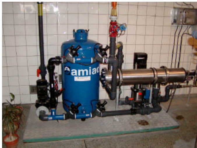
Figur 19: Sandfilter og UV-anlæg
