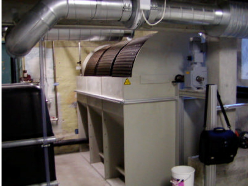
Roterende biologisk kontaktfilter
