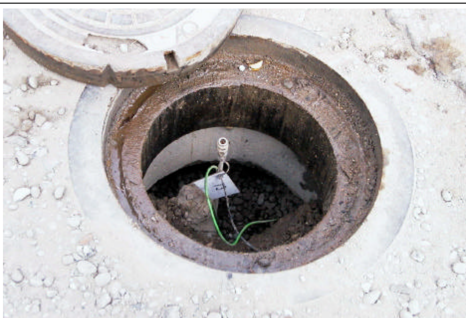
Figur 3.3 Vakuum/injektionsboring hvor der skulle have ligget leca-sten op til toppen af nøreluftrøret
