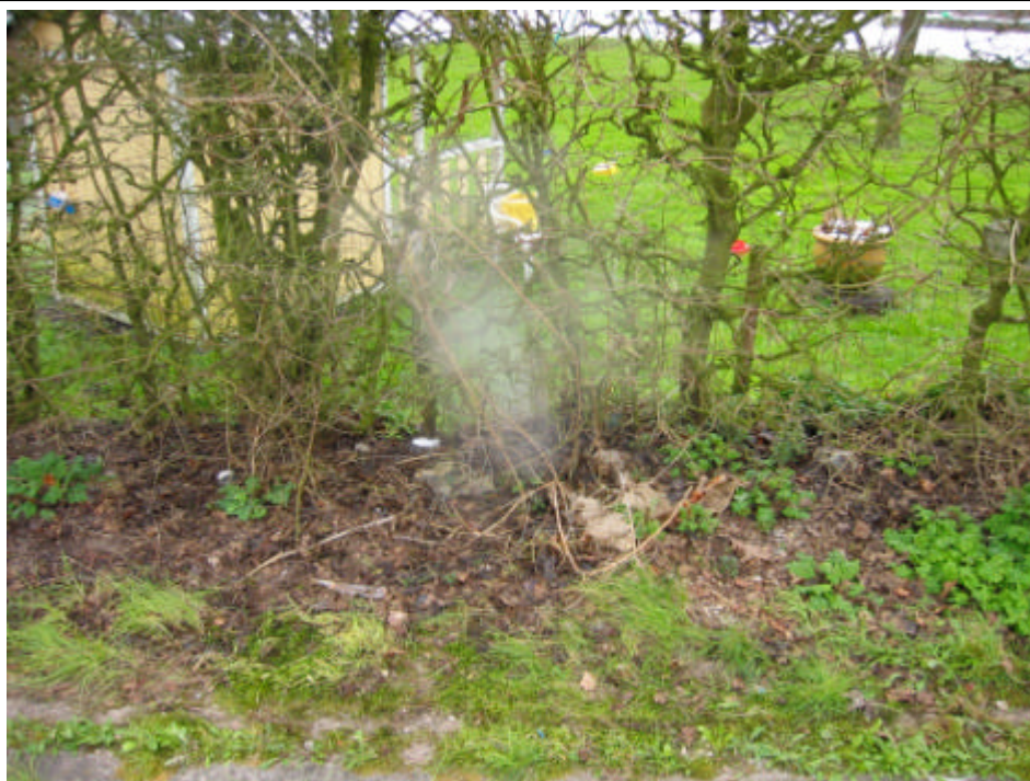
Figur 3.16 Damp strømmer op fra jorden via hækens rodsystem
