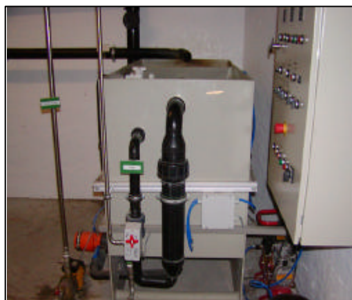
Figur 2.10: Sandfilter med automatisk retur-skylling
