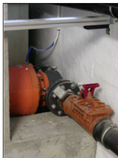
Figur 2.4: Overløbsventil og vandlås
