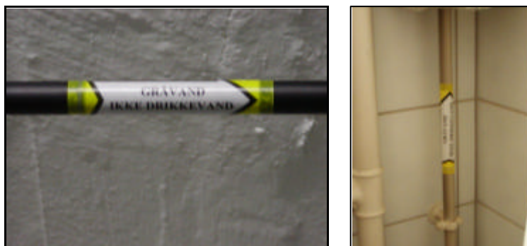
Figur 2.3: Rørafmærkning i kælder og i lejlighederne.
