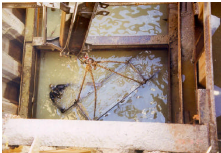
Figur 12 Anlæg af den reaktive vægs nedre del med deltagelse af dykker.
