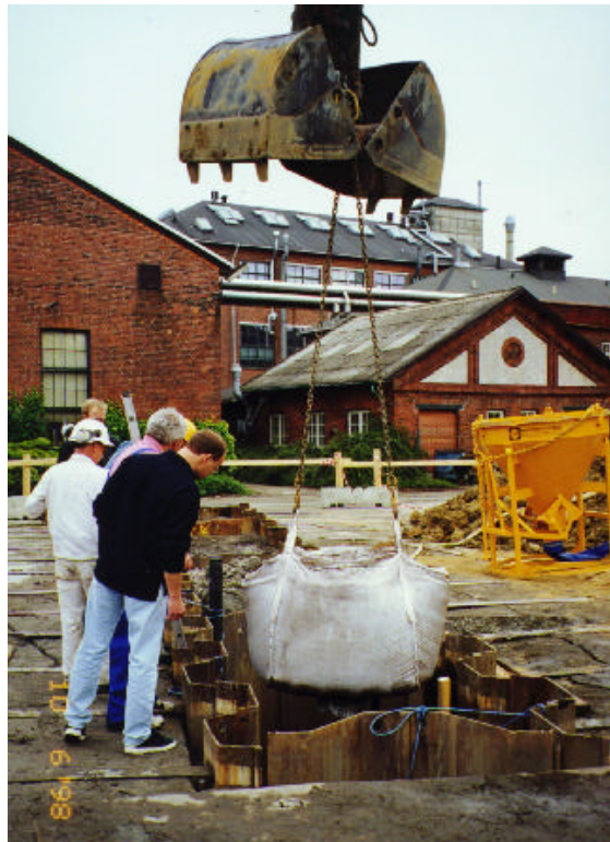
Figur 18 Væggen i Godsbanegården under opbygning.
