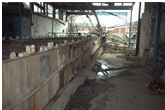
Figur 4 Hårdkrom før nedrivningen. Øverste billede viser gullig chromforurenset væg samt chromholdige gruber. Nederste billede viser affedtningsbadene, hvor TCE har været anvendt.
