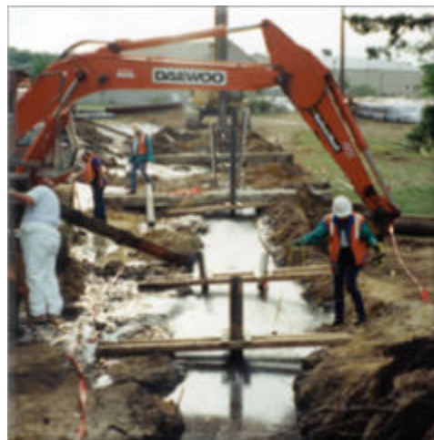
Figur 3 Konstruktion af jernvæg ved hjælp af bioslurrymetoden.
