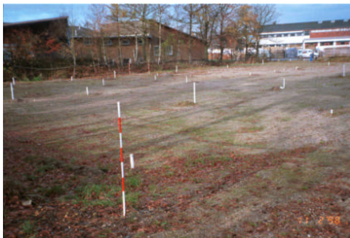
Figur 5 Hårdkrom-grunden efter nedrivning og før etablering af afværgeprojekt
