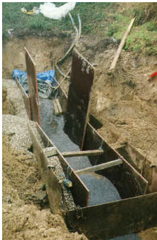
Figur 7 Væggen på Hårdkrom-grunden under konstruktion. Billedet viser gravekassen, hvor i jernspånerne placeres i midten med gruslag på begge sider.
