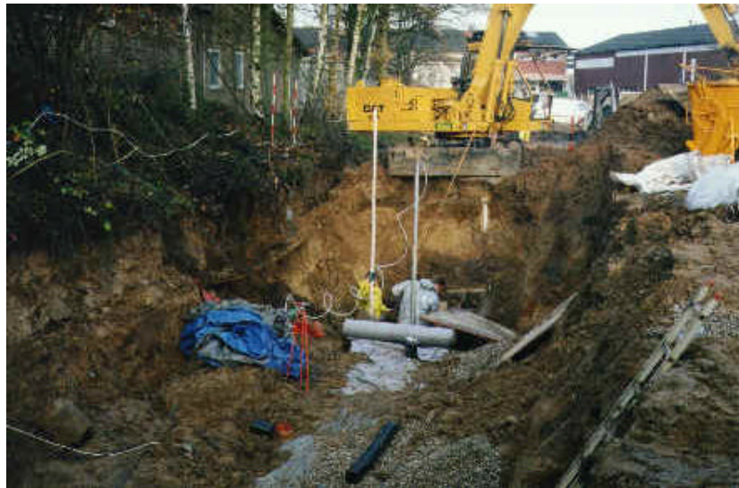
Figur 6 Etablering af reaktiv væg på Hårdkrom-grunden. En af borerne placeret i væggen ses midt i billedet.
