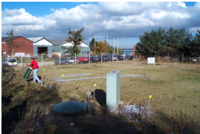
Figur 10 Det færdigetablerede afværgesystem på Hårdkrom-grunden, oktober 2000. Nedsivningsdrænene er markeret med gule pæle.
