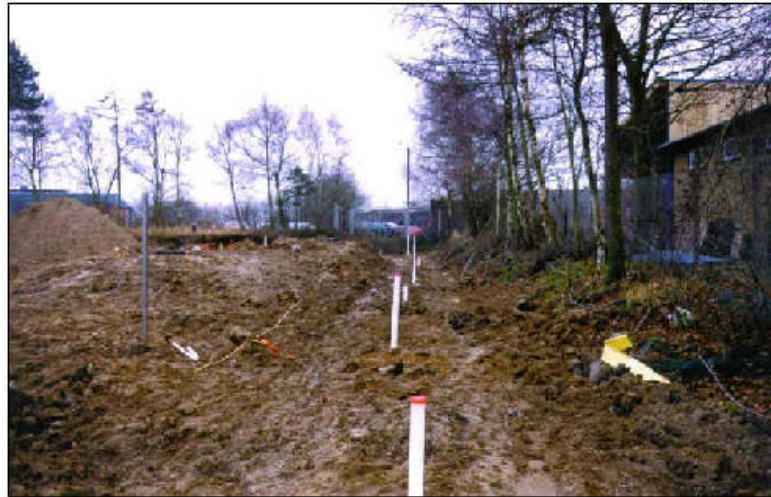
Figur 8 Den reaktive væg set fra nord med nedstrøms monitoringsboringer (midt i billedet).
