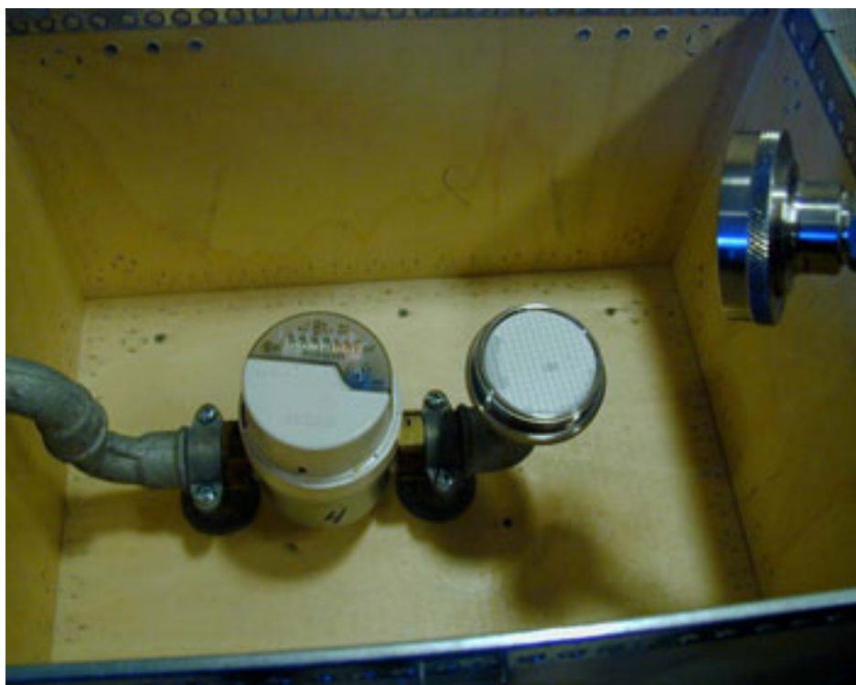
Figur 3 Den øverste del af fil treringsenheden skrues på igen.
