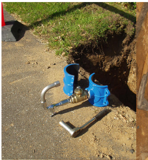
Figur 4.2: Anboringsbøjle og prøvetagningshane
