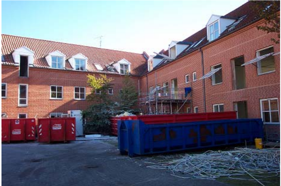
Nedrivningspladsen med containere til de forskellige fraktioner.
