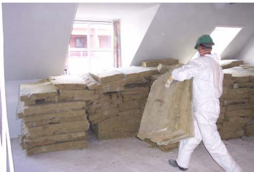
Stabling af den udtagne brugte stenuld
