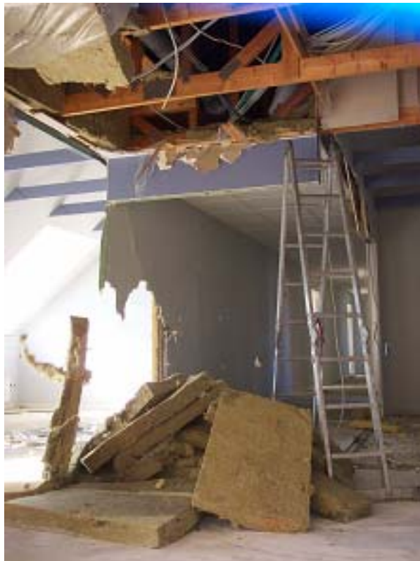
Udtagning af brugt stenuld fra loftsrum
