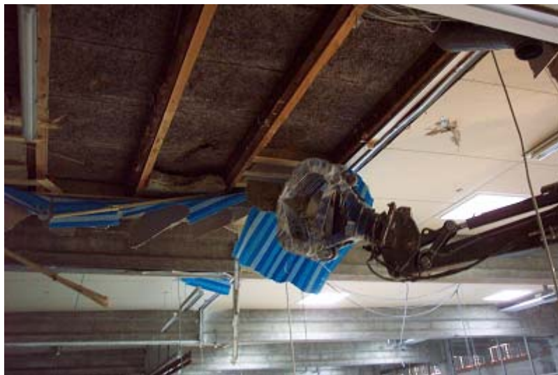
Udtagning af isoleringen fra loftet i hallen.
