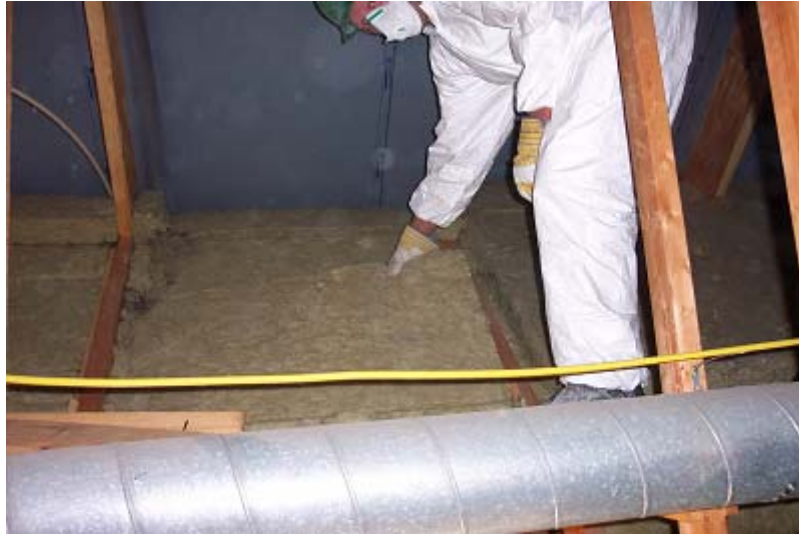
Udtagning af isoleringen på loftet i tagetagen.
