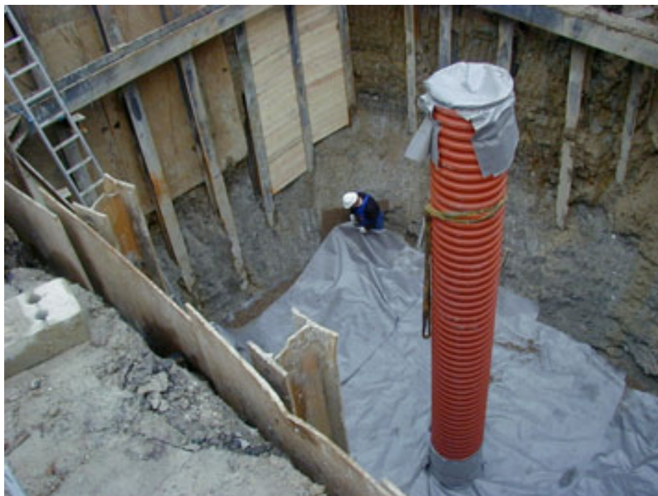
Figur 3.9: Udgravning indenfor københavnerg med afstivningsramme
