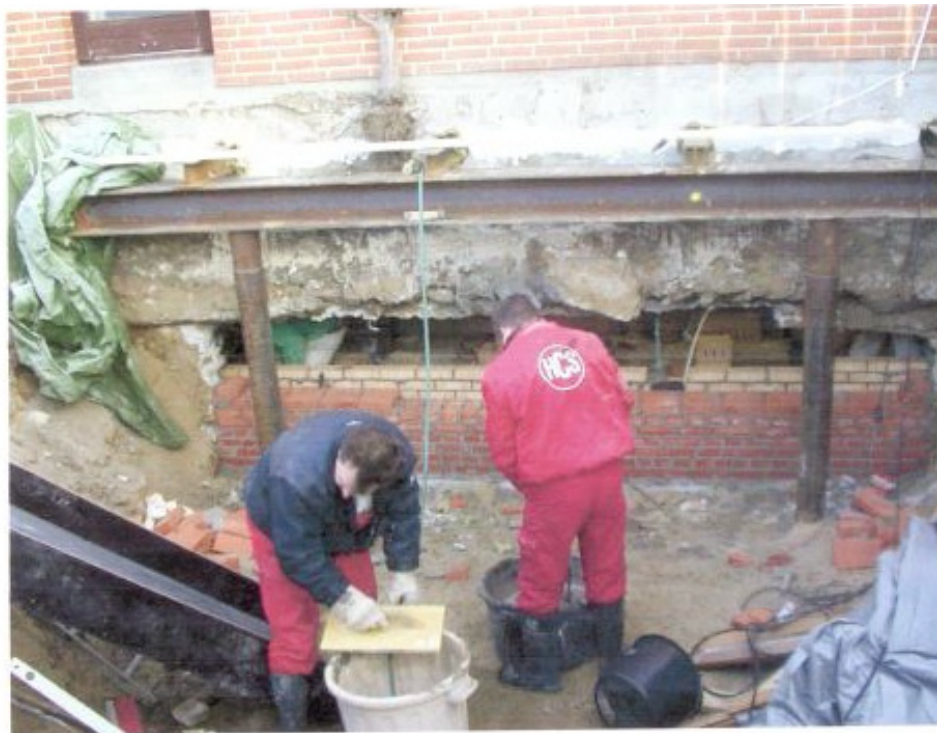
Figur 3.13: Stålpæle med dragere og tværbjælker afstiver bygning. Fundament undermures
