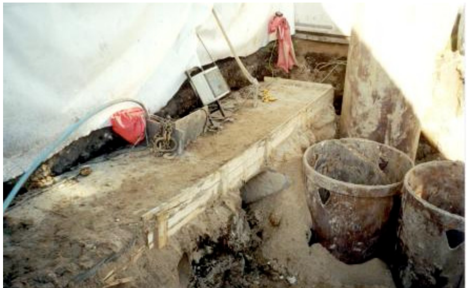
Figur 3.5: Til venstre ses toppen af en 10 m dyb sekantvæg; til højre ses 8 m dybe stålforingsrør for opborring af forurenet jord.
