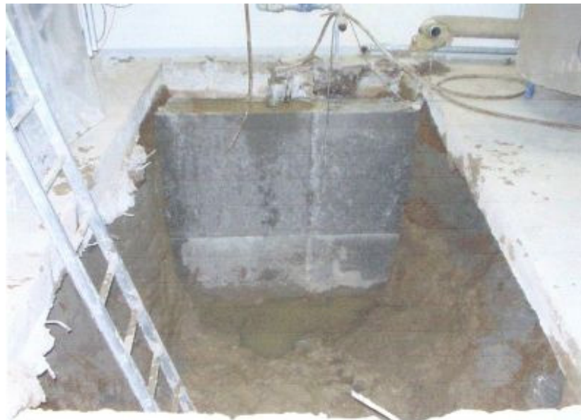
Figur 3.12: Færdigetablet fundamentsunderstøbning
