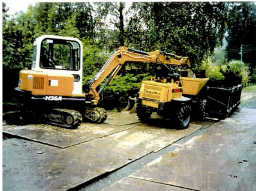
Figur 3.1: Arbejdspladsindretning med beskyttende køreplader og container samt minigravemaskine og minidumper
