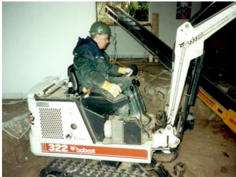
Figur 3.3: Minigravemaskine og transportør i stue
