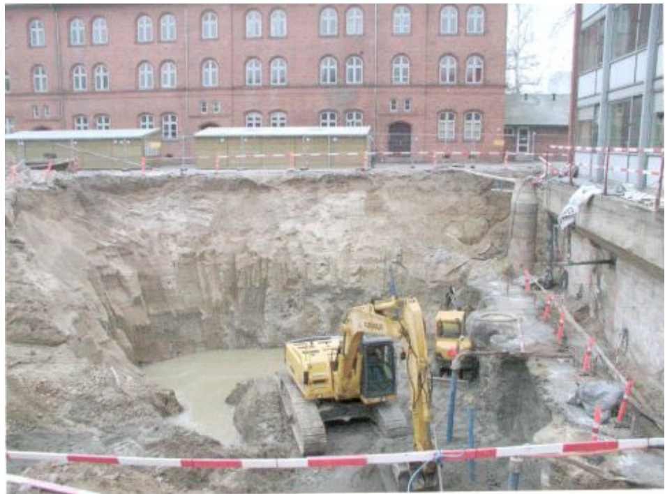
Figur 3.2: Fri udgravning med stejle skråninger. Til højre ses grundvands-sænkingsboringer (blå) samt en sekantvæg til støtte af bygningen. (Odense kaserne)
