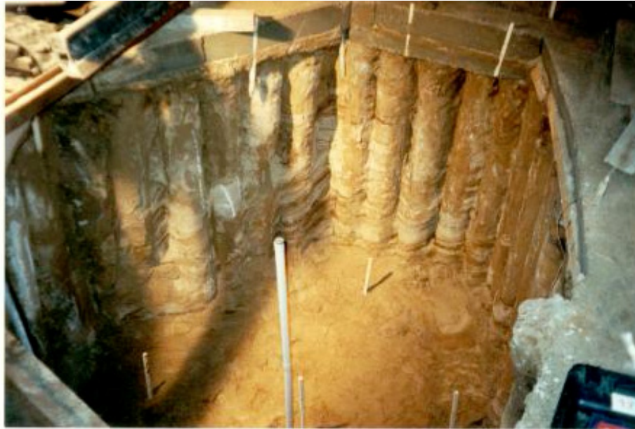
Figur 3.11: Sekantvæg under stue
