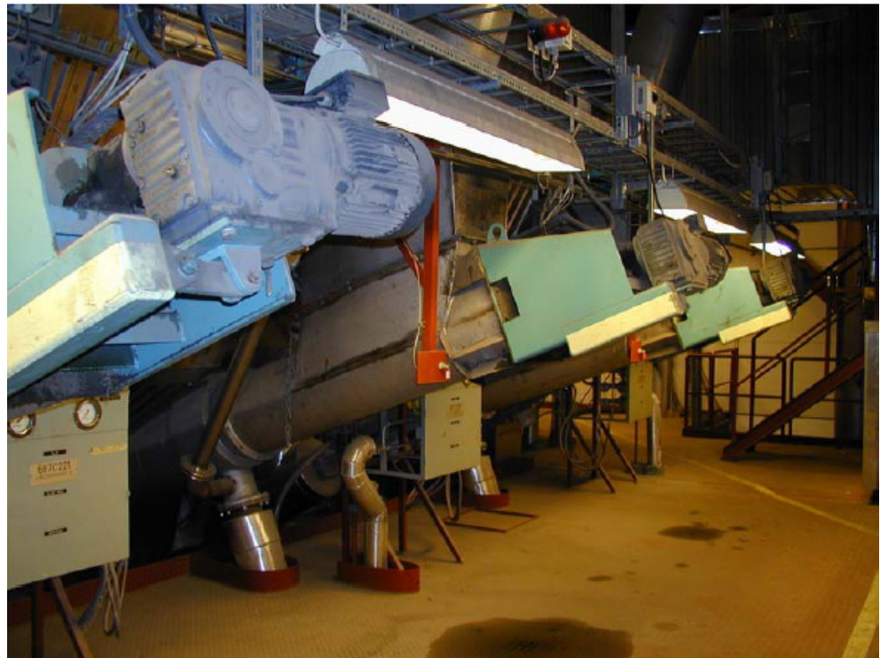
Figur 3. Tre af de fire skruefødere til igelstaverkets kedel 3.
