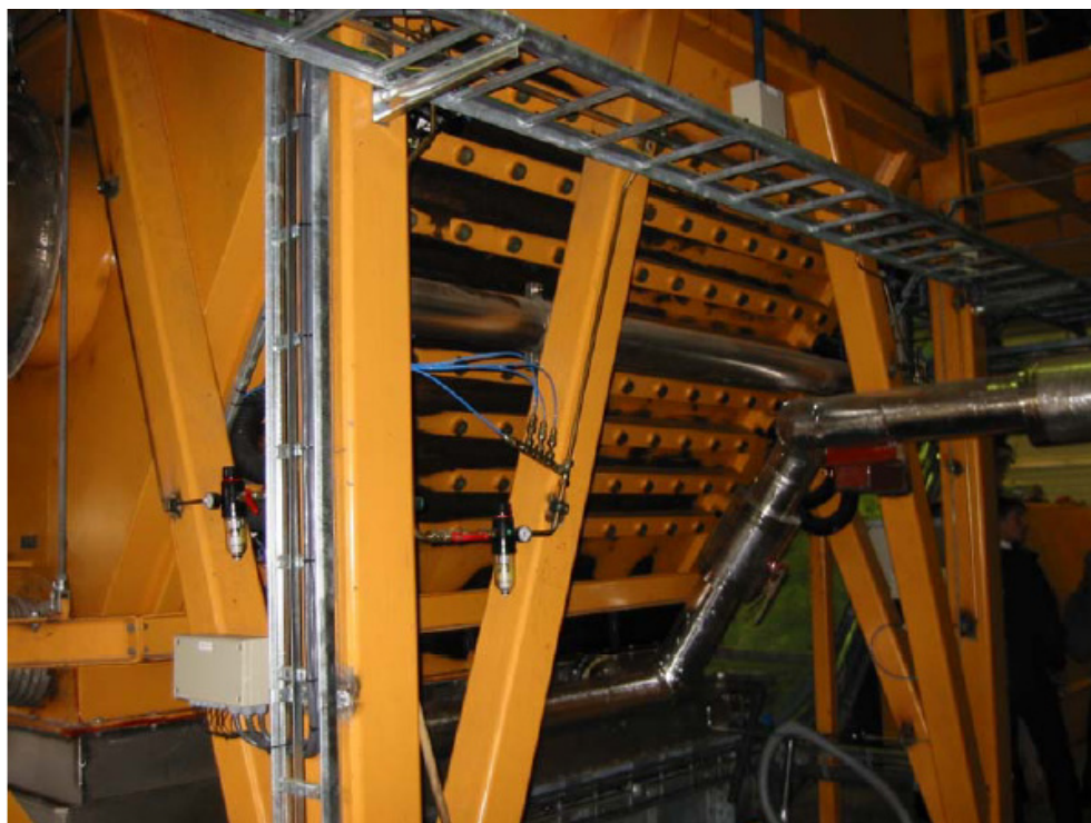
Figur 3. Manifold til luftdyser i bunden af forgasningskammeret.
