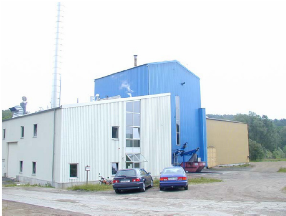
Figur 1. Forgassingsanlægget ved Siebenlehn.
