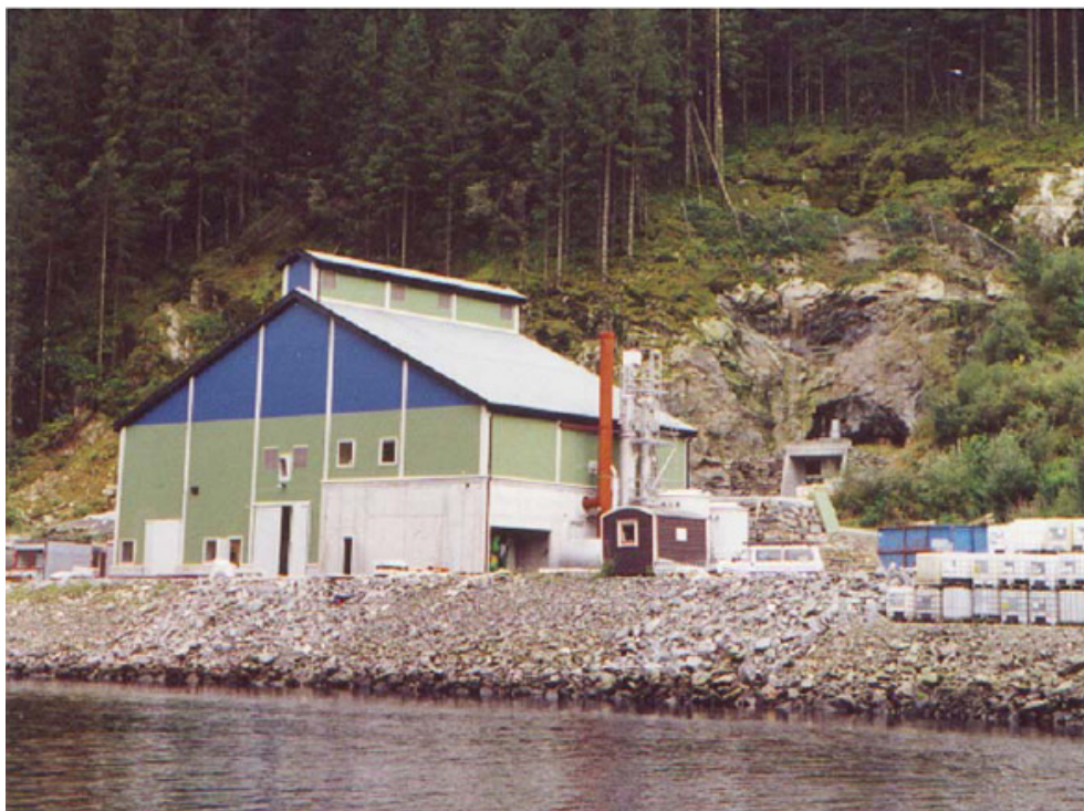
Figur 1. Pyroarc anlægget ved Borge garveri.
