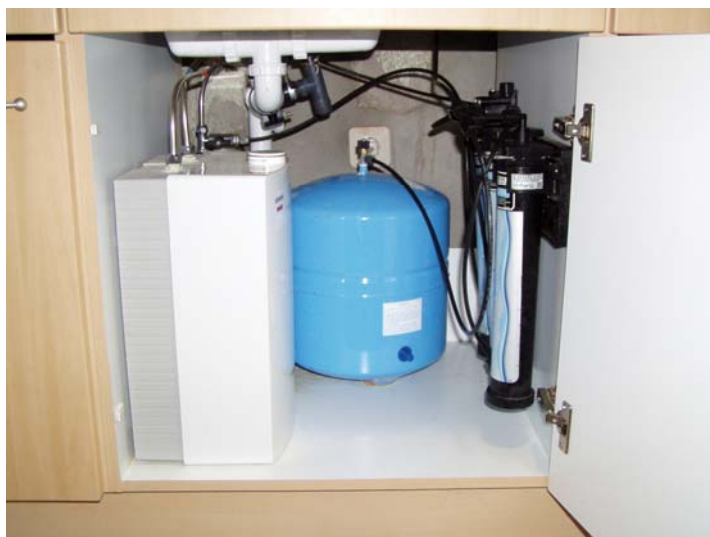
Figur 5. POU omvendt osmose anlæg for nitratreduktion. Placeret under køkkenvask. Til højre ses 3 ens beholdere for partikelfiltrering, aktivt kul filtrering og omvendt osmose. I midten ses rentvandsbeholderen og til venstre ses køleanlægget for køling af vandet i rentvandsbeholderen.
