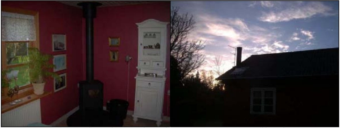
Figur 25. Eksempel 6: 0,5 m ekstra skorsten er monteret, men er ikke nok. Røgsuger anbefales
