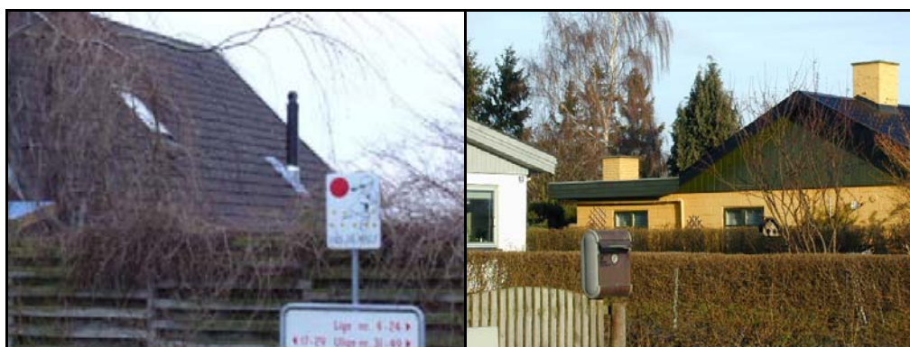
Figur 1. Eksempler på lave skorstene i forhold til bygningerne. På billedet til højre, er det skorstenen på den lave tilbygning
