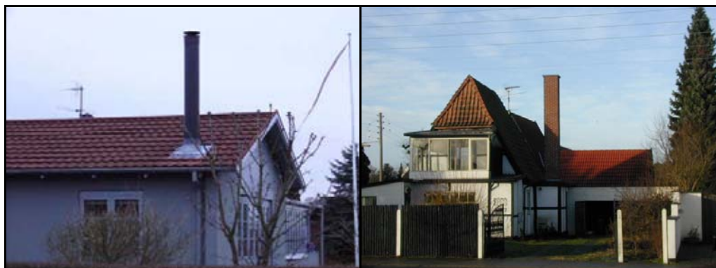
Figur 3. Eksempler på meget høje skorstene i forhold til tagfladen
