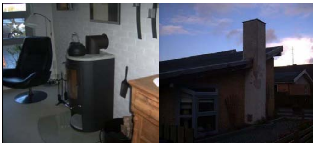
Figur 26. Eksempel 7: Isokern monteret. Ejer overvejer også at afkorte røgvendepladen
