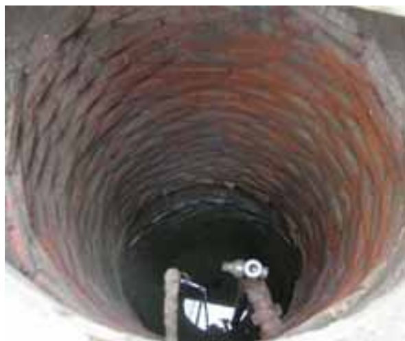
Brønd, beliggende under halvtag ved hus. Brønden er klokkeformet og vandet indvindes fra et større "kammer" ca. 4 meter under terræn. Vsp ca. 3 mut.
