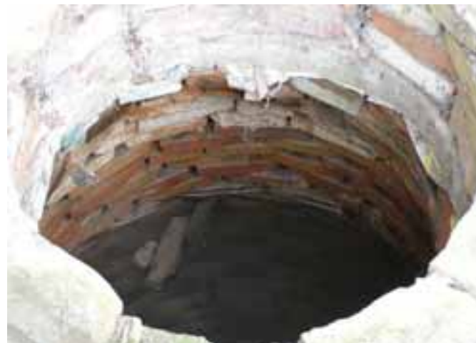
Brønd er konstrueret af løse mursten, og kun i den øvre del er der anvendt mørtel. Det har regnet natten før billede blev taget – læg mærke til at vandet strømmer til ved indsivning i mur over grundvandsspejl.
