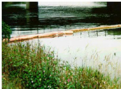
Figur 6: Spærring med opsugningsmiddel
