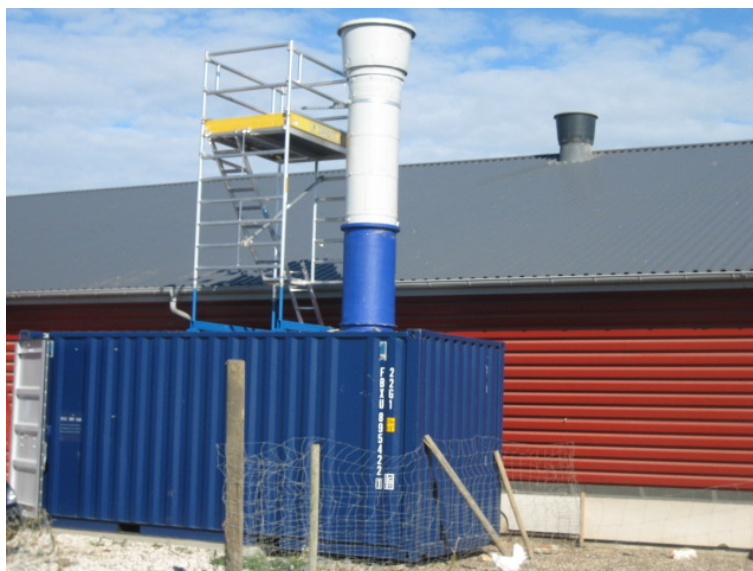
Figur 2. Farm Airclean fra SKOV A/S – kemisk renser i pilotapplikation ved fjerkræstald.
