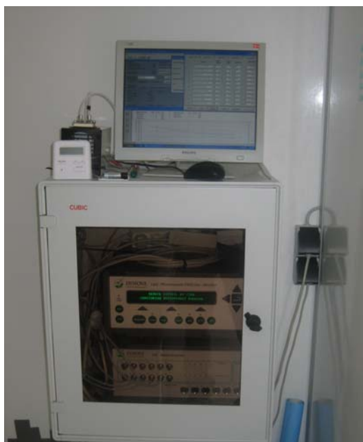
Figur 4. Innova Photoacoustic Field Gas-Monitor 1412. opstillet i Dansk Landbrugsrådgivnings målevogn ved renser.
