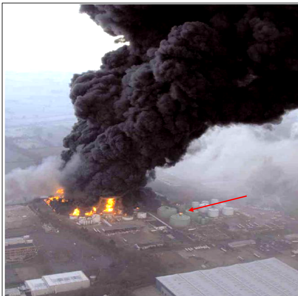
Figur 6.6 Brand ved Buncefield under udvikling. Bemærk brande fra udluftningsventiler og rim seal brande på nærliggende tanke, der endnu er intakte /ref. 16/
