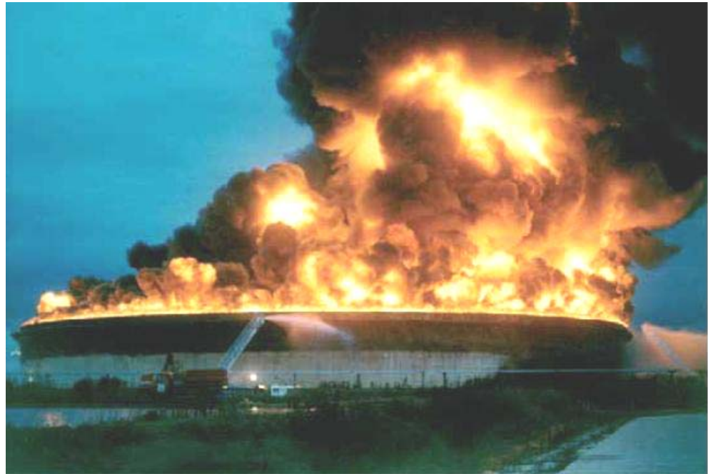
Figur 6.1 Orion Refinery, Norco, Louisiana, USA, 2001. Lynnedslag forårsager brand i 52.000 m 3 lagertank med benzin, /ref.16/
