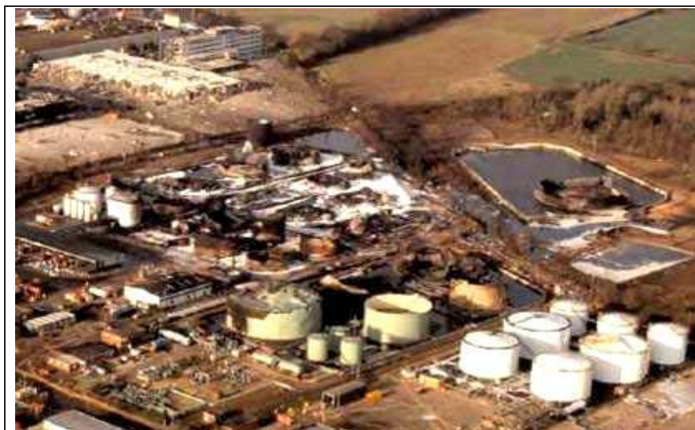
Figur 6.7 Ulykkesområde efter slukning af branden, der varede i 4 døgn. Bemærk de ødelagte bygninger i baggrunden /ref. 16/
