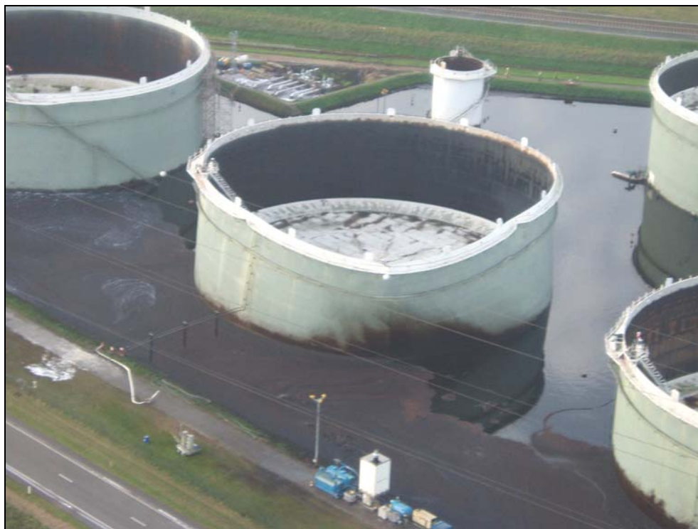
Figur 6.5 Udslip af råolie fra revnet tank i Kello i Belgien, 2005 /ref. 4/
